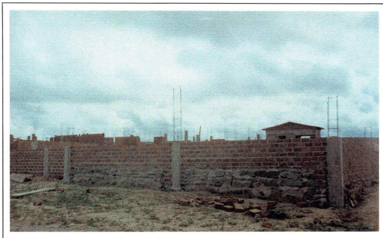
Foto 15: alvenaria de embasamento (pedra argamassada)
