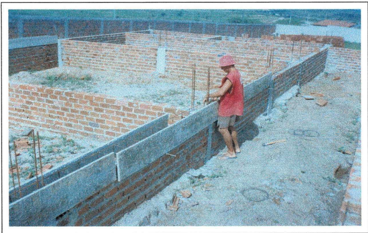
Foto 14: alvenaria de embasamento (tijolos de 1 vez)
