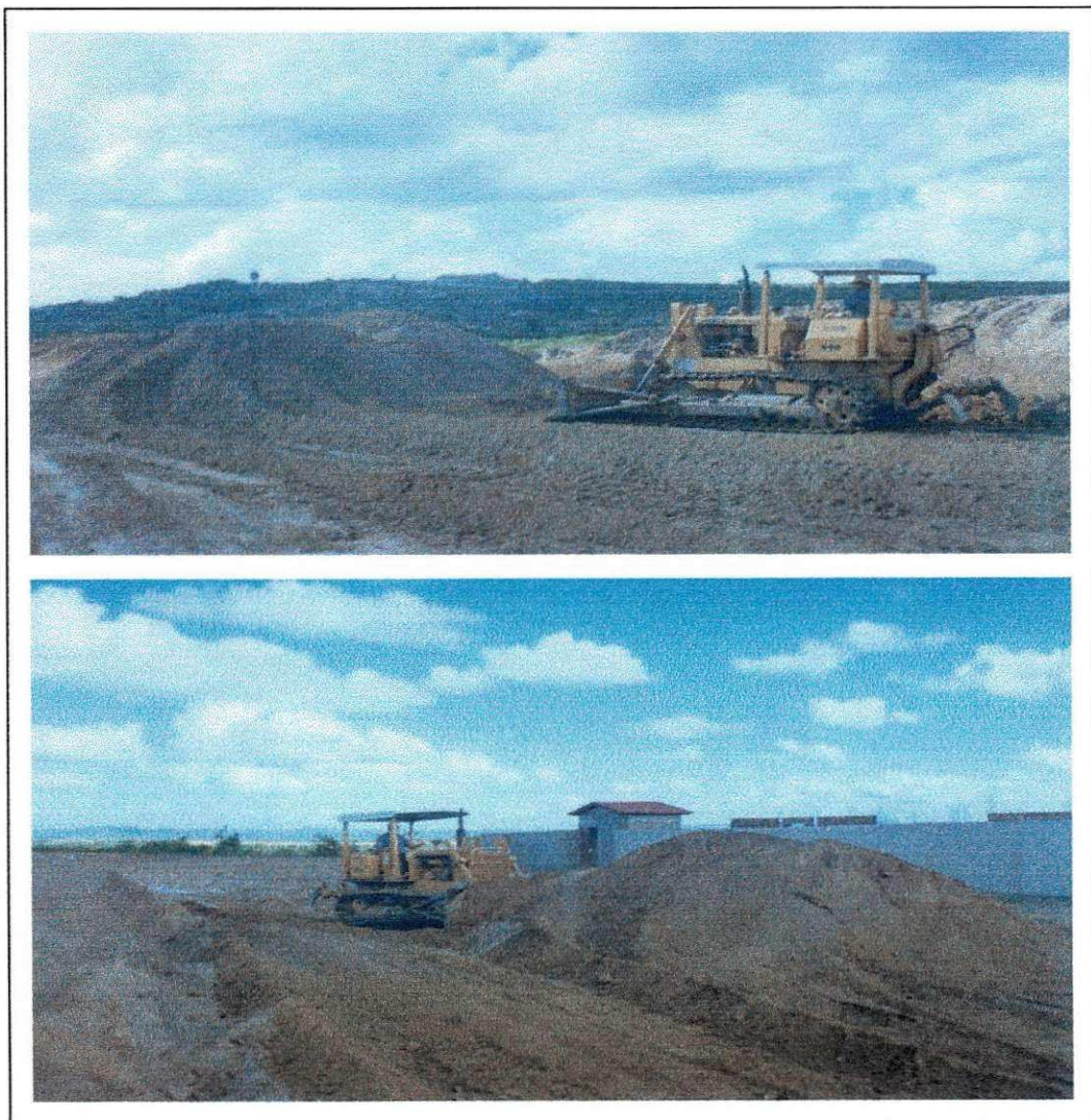
Foto 12: material para aterro
