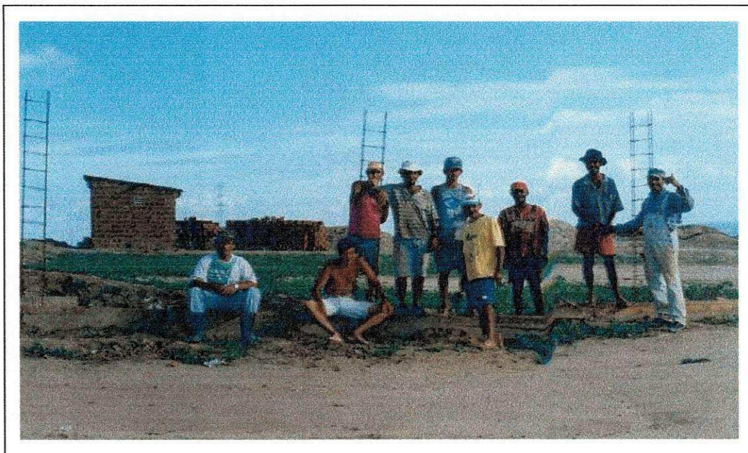
Foto 1: alguns operários da obra
