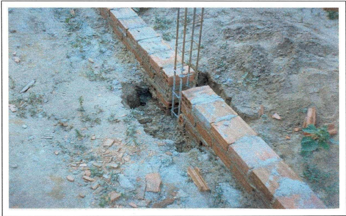
Foto 16: fundação rasa (sapata)
