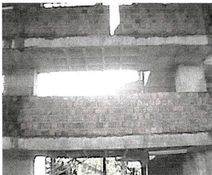
FIGURA 3 – ALVENARIA DE VEDAÇÃO
