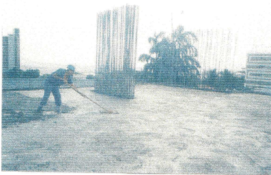
FOTO 10 - DESEMPOLAMENTO DO CONCRETO DA LAJE
