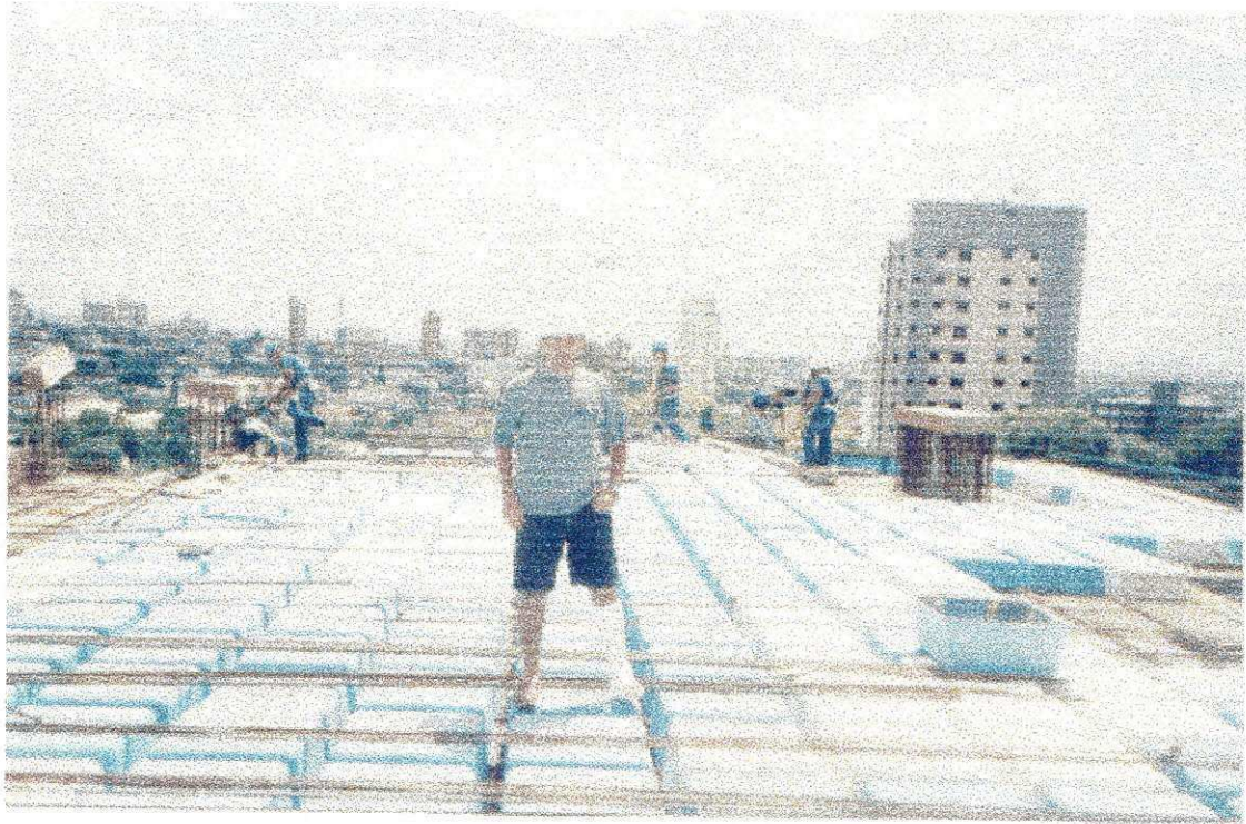
FOTO 07 – COLOCAÇÃO DA FERRAGEM NEGATIVA DA LAJE
