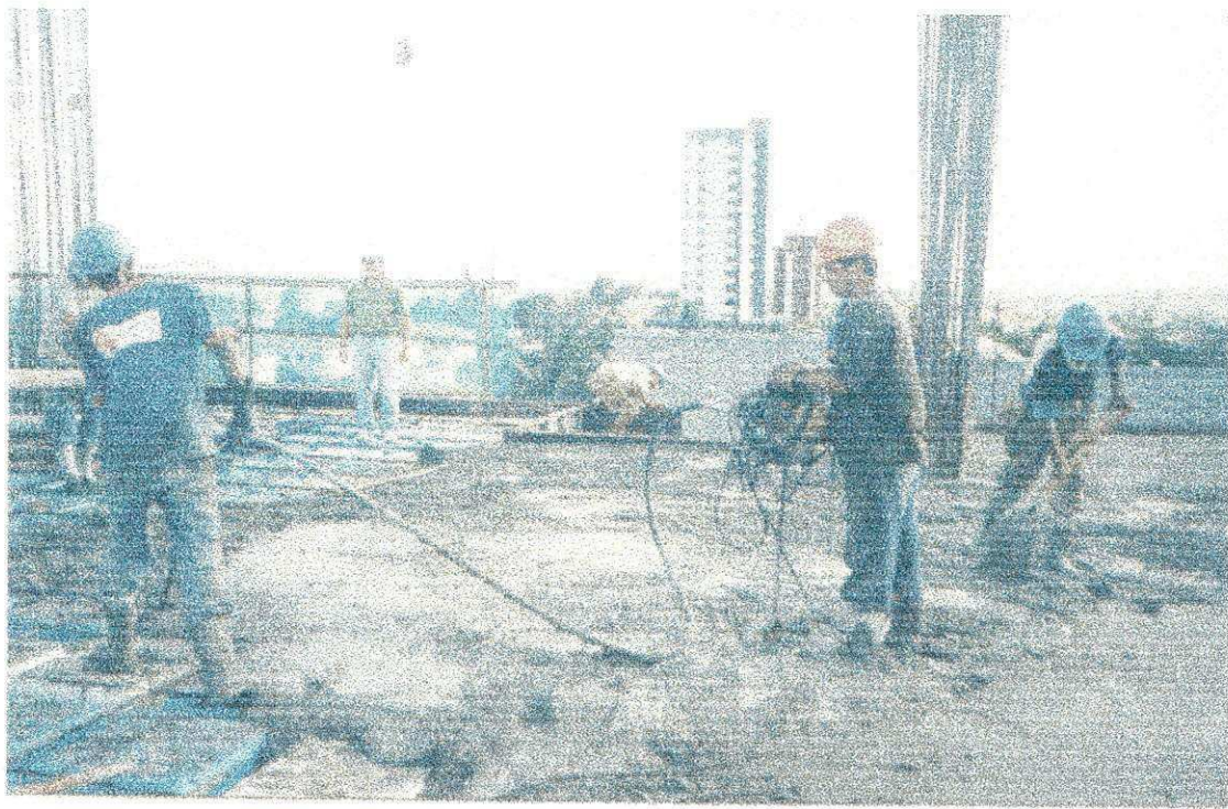
FOTO 09 - CONCRETAGEM DA LAJE DO PAVIMENTO TIPO
