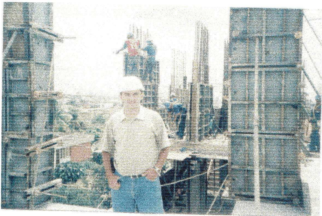
FOTO 03 – FORMAS DOS PILARES
