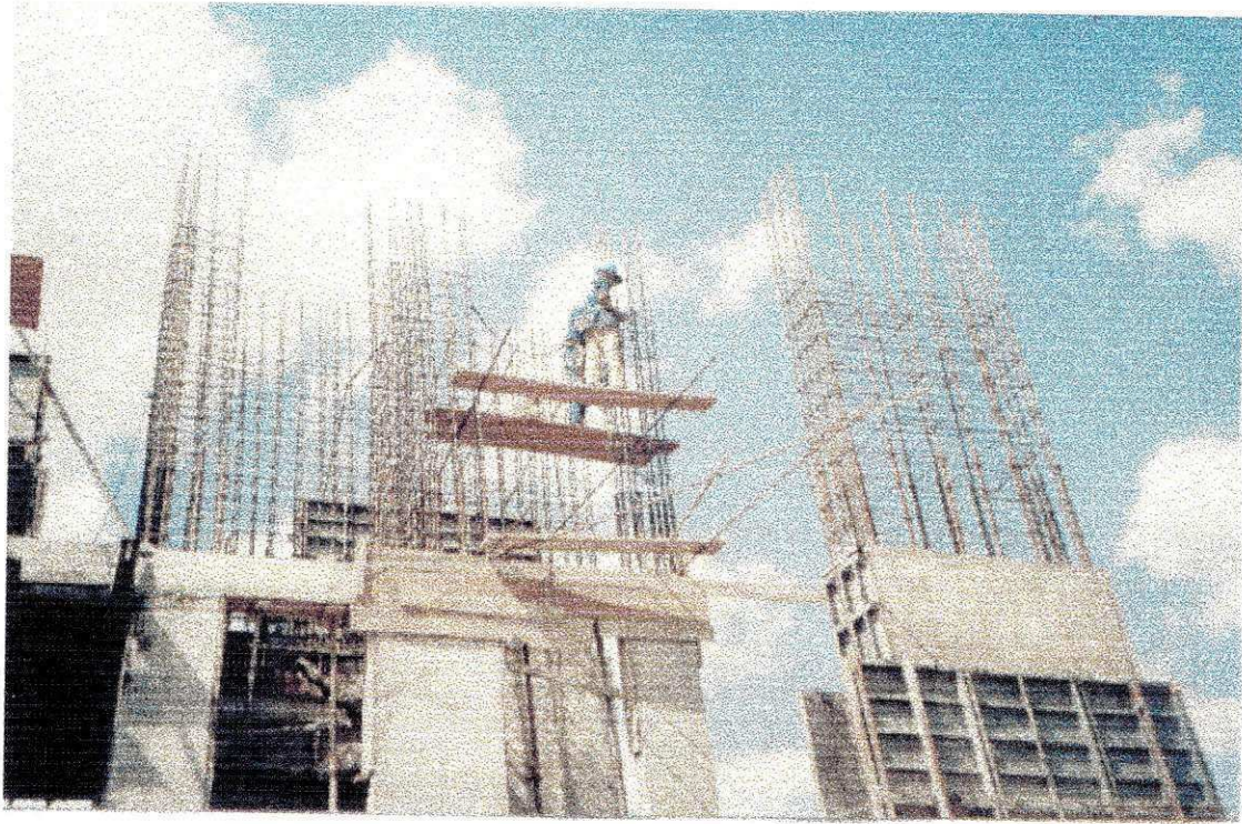
FOTO 01 – FERRAGEM DOS PILARES
