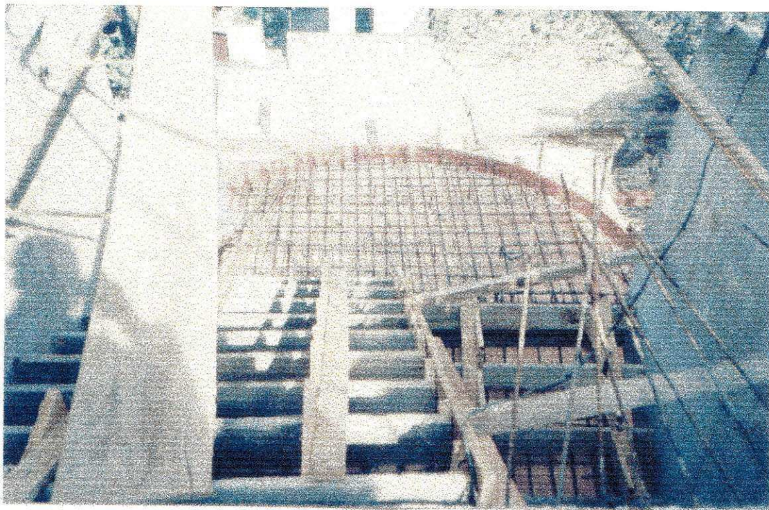
FOTO 05 – FERRAGEM E FORMA DA ESCADA
