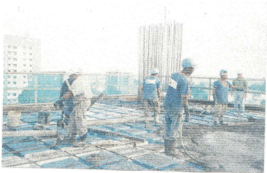
FOTO 08 – CONCRETAGEM DA LAJE DO PAVIMENTO TIPO
