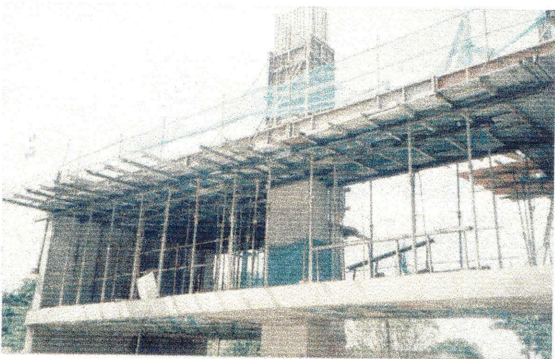
FOTO 02 – ESCORAMENTO DO MEZANINO
