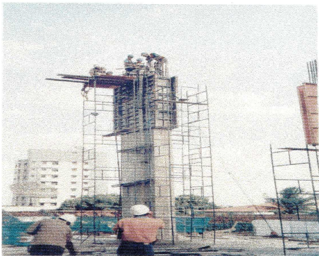
FOTO 04 – CONCRETAGEM DO PILAR
