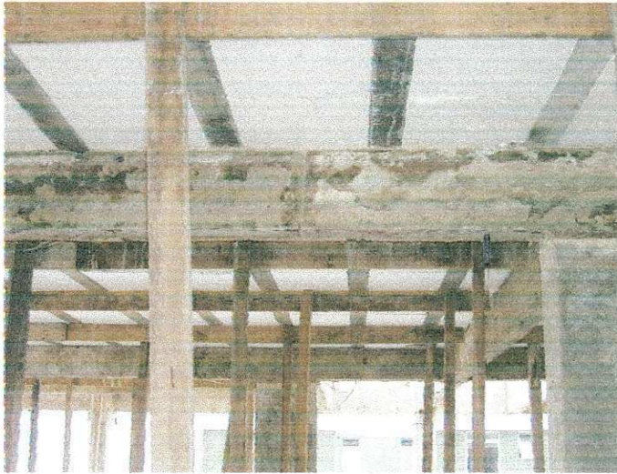
FIGURA 05 – Escoramento da laje
