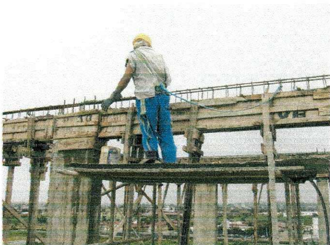
FIGURA 12 - Trabalhador usando equipamentos de proteção: cinto, luvas e capacete.
