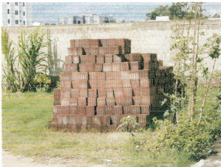
FIGURA 08 – Armazenagem dos tijolos
