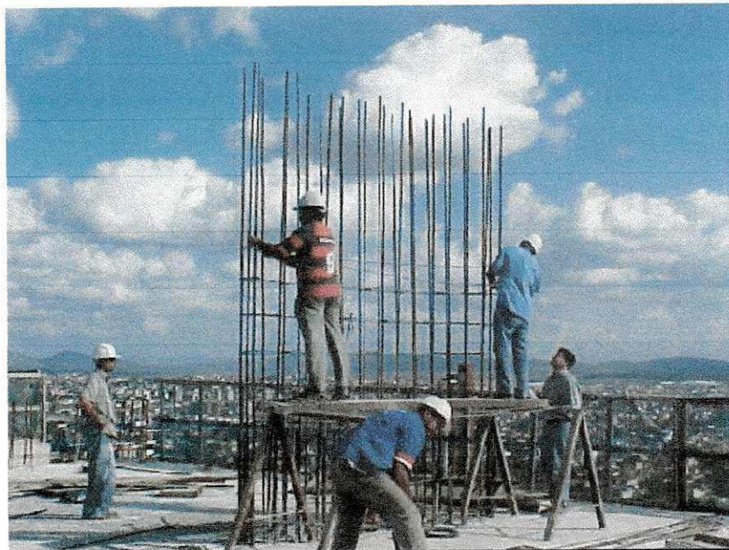
Figura 2 - Armação dos pilares
