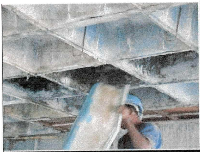
Figura 4 – Retirada das formas das Lajes
