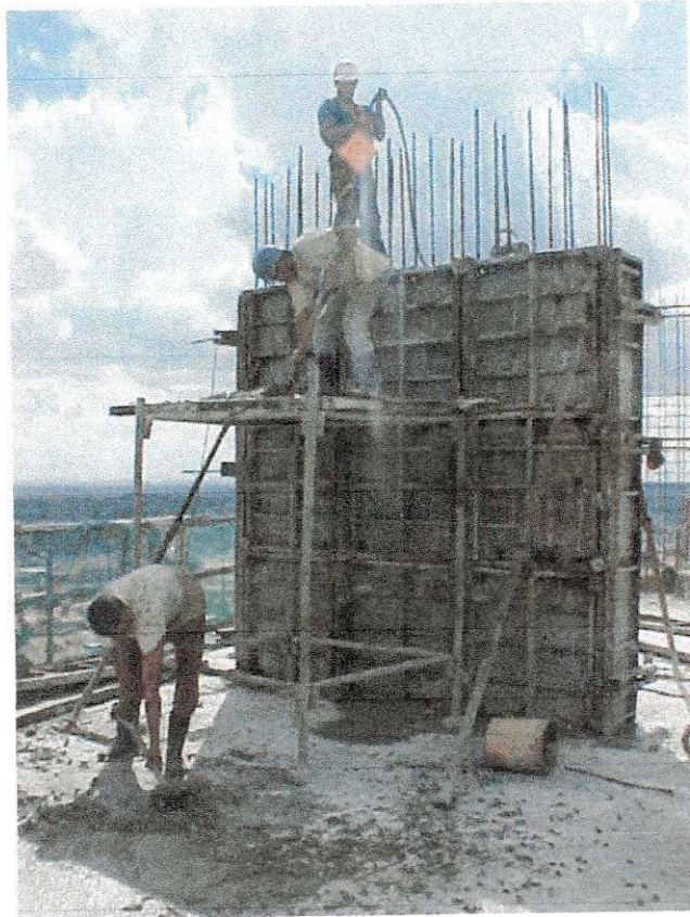
Figura 3 – Concretagem dos pilares
