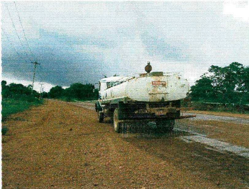
Figura 6.2( Caminhão Pipa umedecendo a base para imprima-la )
