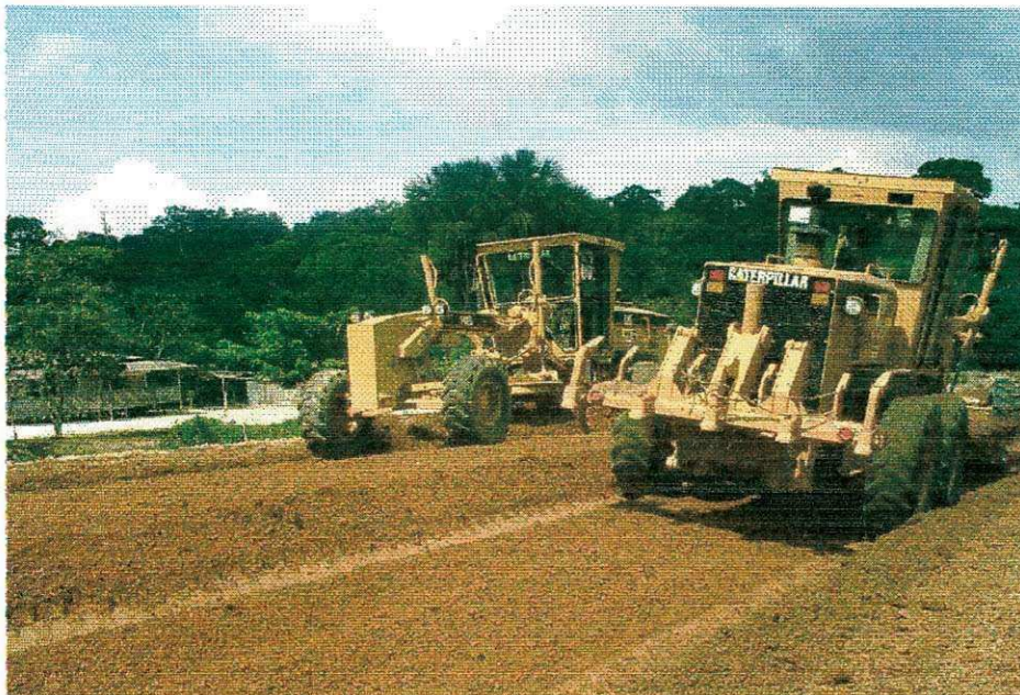
Figura 5.2 ( Motoniveladora homogeneização do material)
