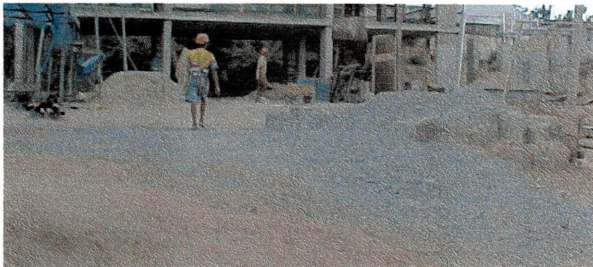
Estocagem dos agregados fig.05
