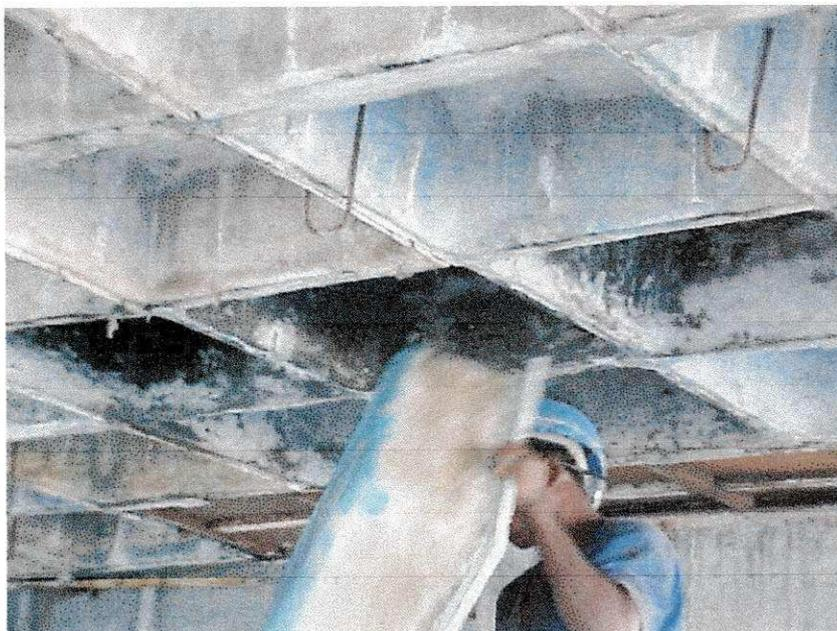
Fig.: desforma de uma laje nervurada
