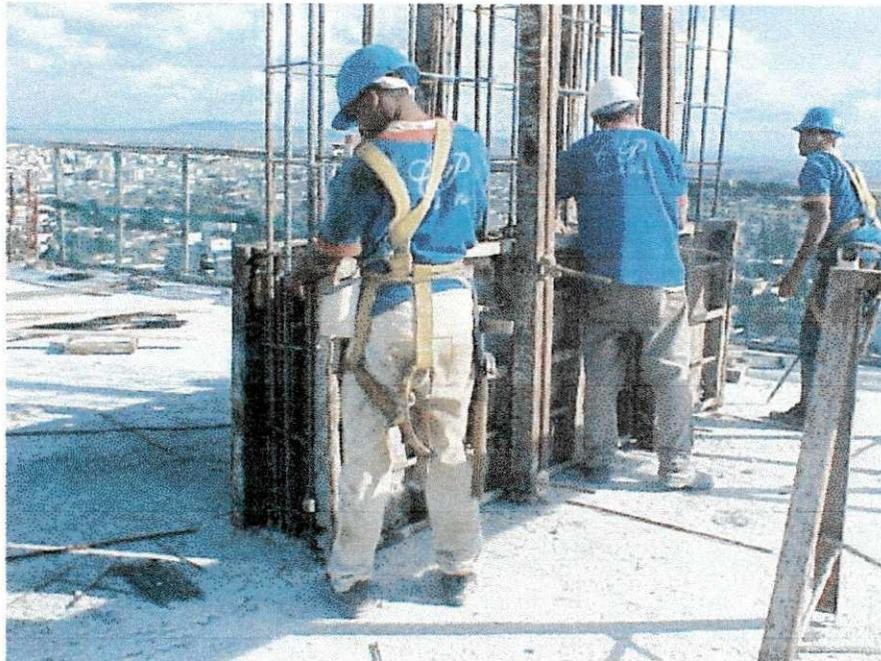
fig. desforma de um pilar
