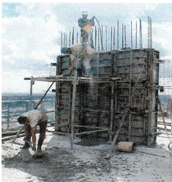
fig.: adensamento do concreto
