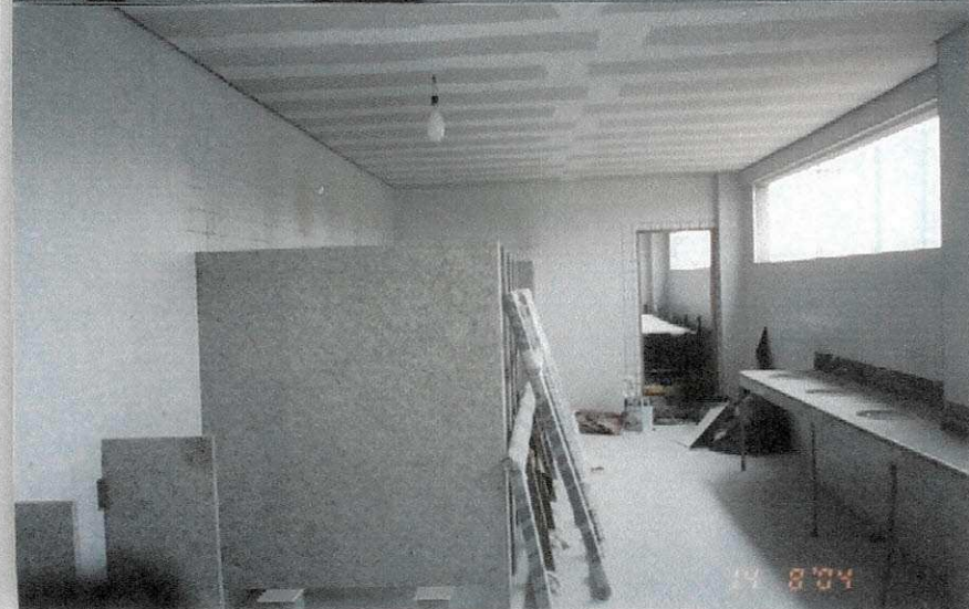
Foto 26 (galpão e alojamento)
