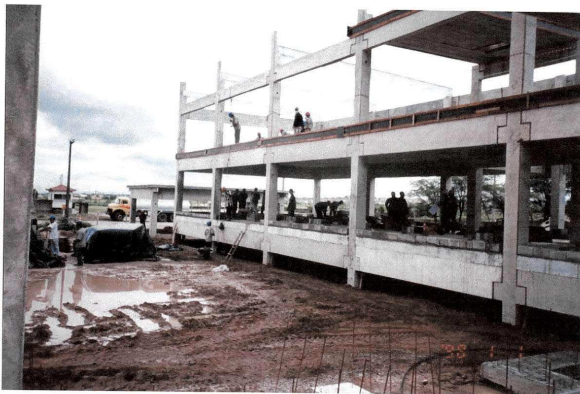
Foto 11 (Montagem dos pilares e vigas pré-moldados – Alojamento)
