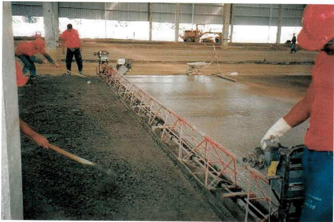
Foto 16 (Aplicação do piso 2)
