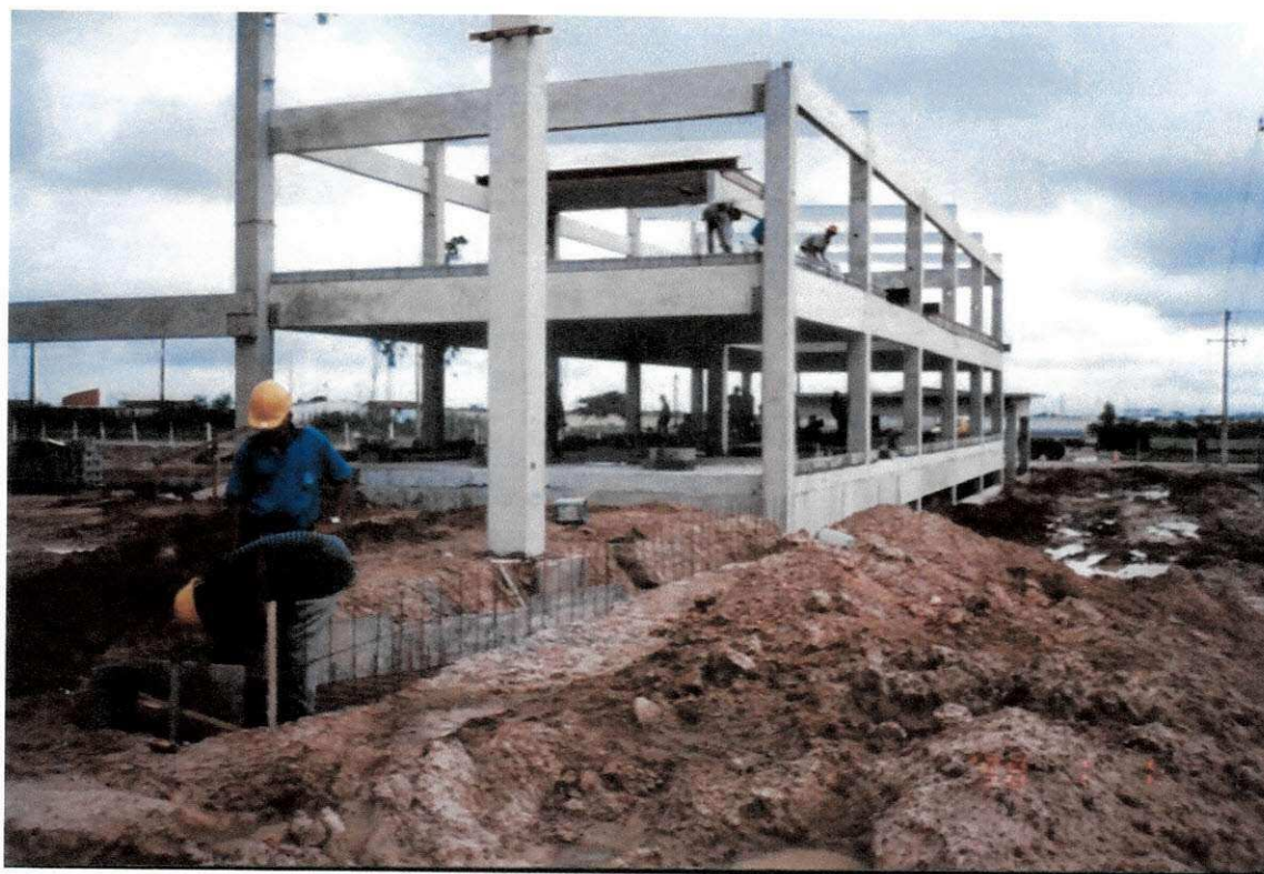
Foto 12 (Montagem dos pilares e vigas pré-moldados – Alojamento)
