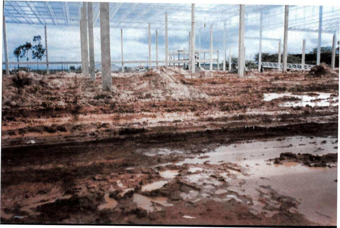
Foto 07 (pilares de concreto)
