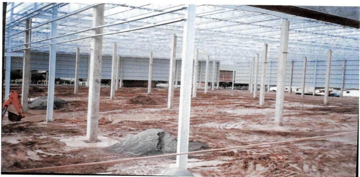
Foto 08 (Pilares de concreto e metálicos)
