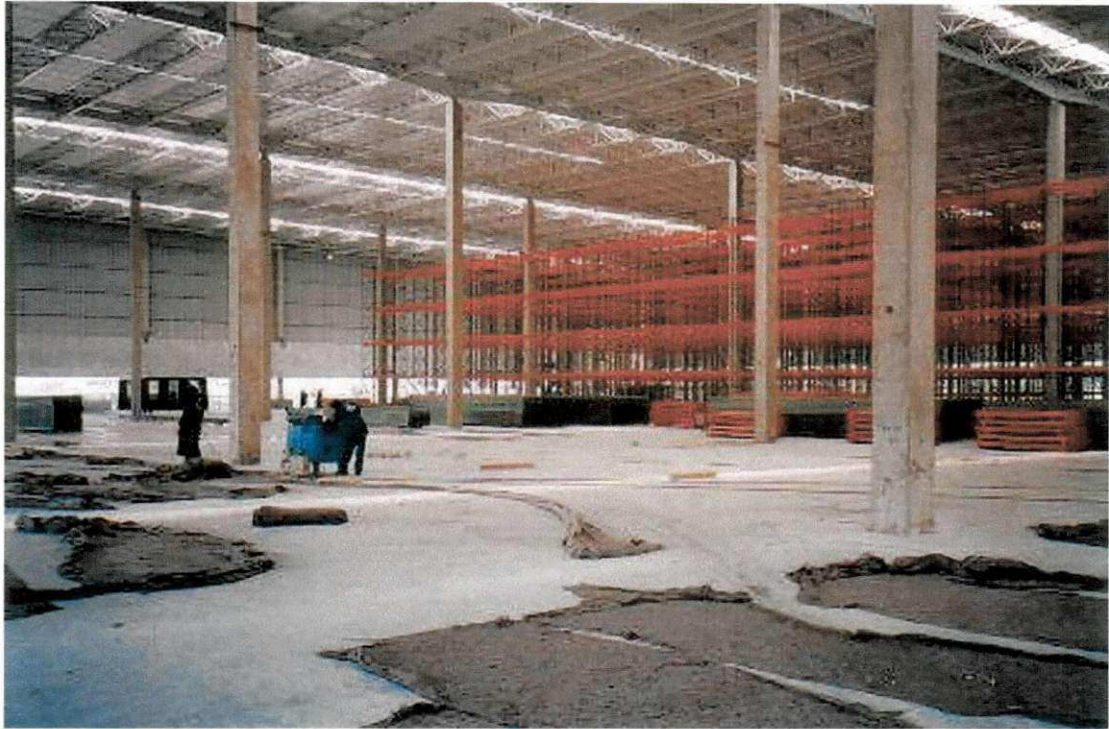
Foto 23 (Vista interna do galpão)
