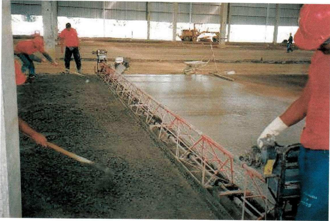
Foto 15 (Aplicação do piso)
