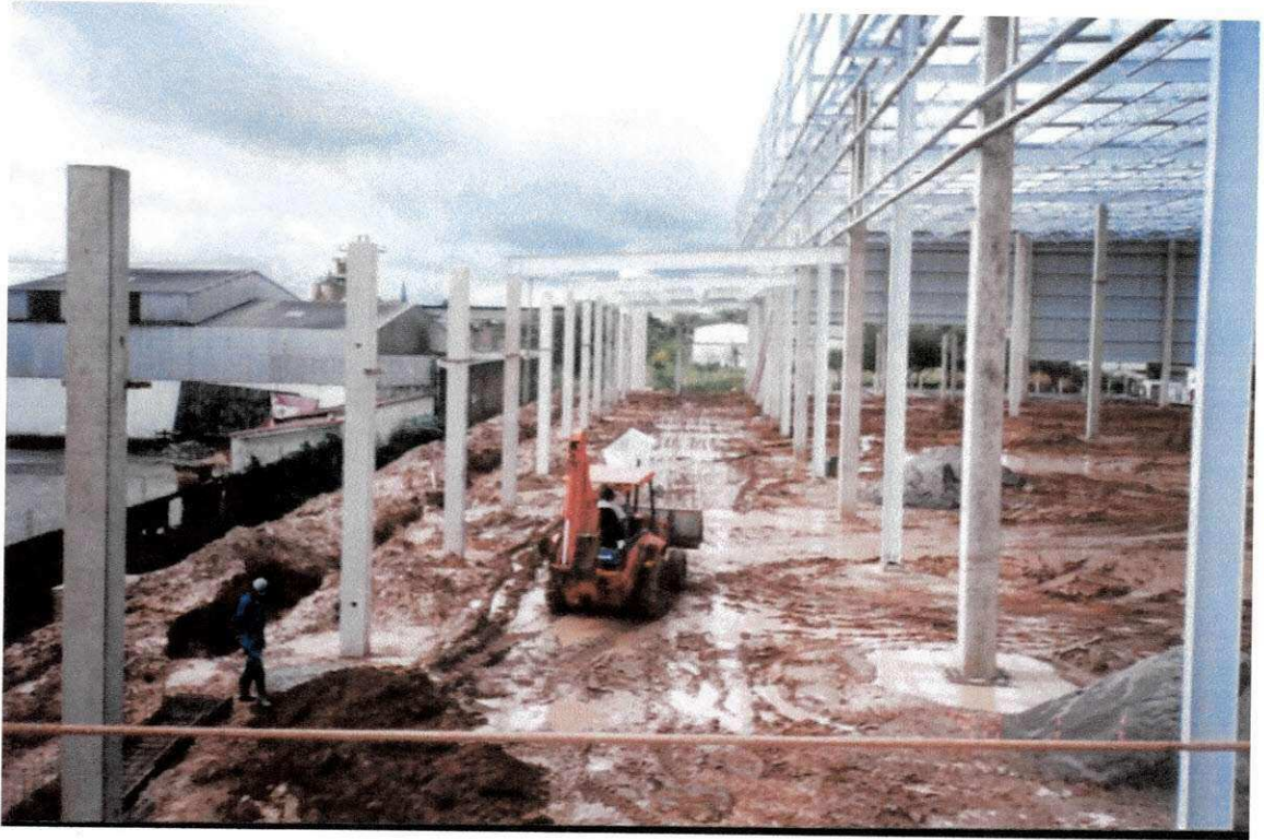
Foto 09 (Pilares de concreto e metálicos)
