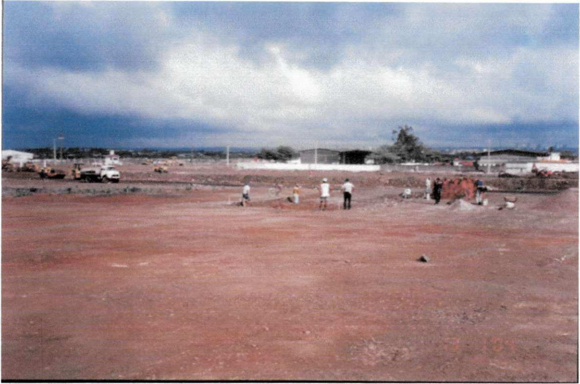
Foto 03 (Instalação do canteiro de obras)
