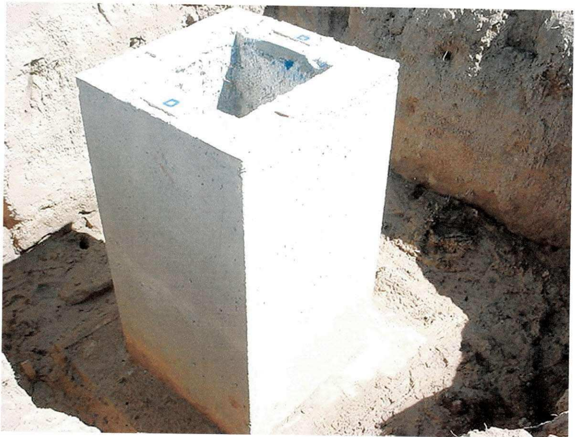
Foto 05 (Bloco de Fundação)
