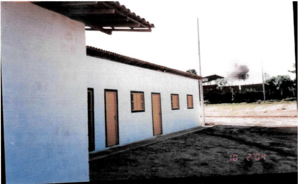
Foto 04 (Canteiro de Obras)
