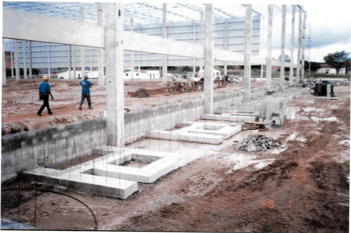
Foto 10 (Alvenaria das baias)
