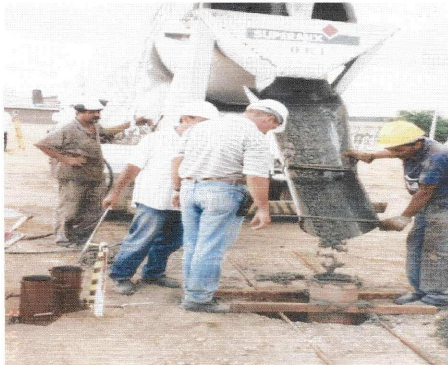
Figura 2 – Concretagem de tubulão com auxílio de tubo para amortecimento da queda
