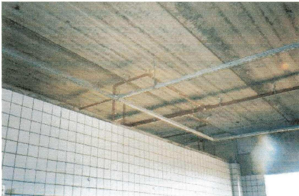
Figura 12 – Detalhe das instalações hidráulicas e elétricas entre a laje e o nível do forro
