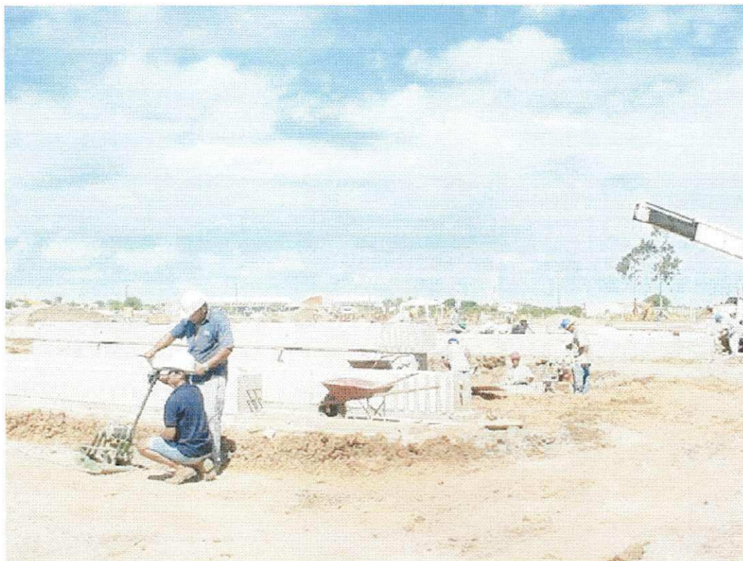
Figura 3 – Pilares pré-moldados sobre bases de concreto
