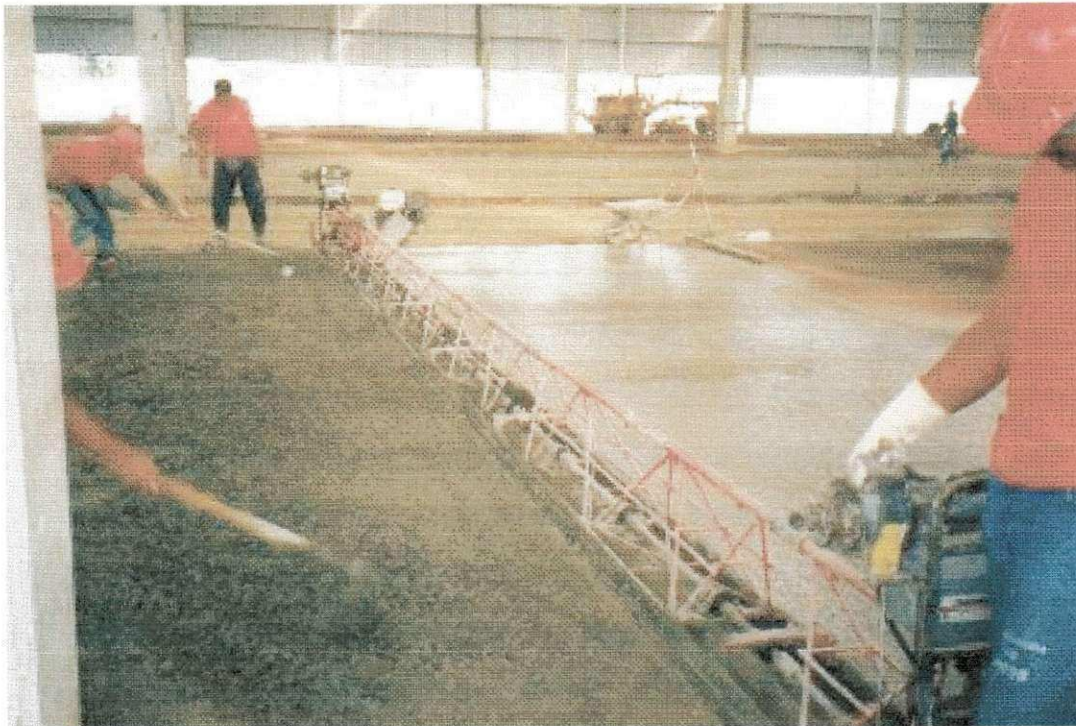
Figura 9 – Concretagem do piso industrial e adensamento com auxílio de régua vibratória
