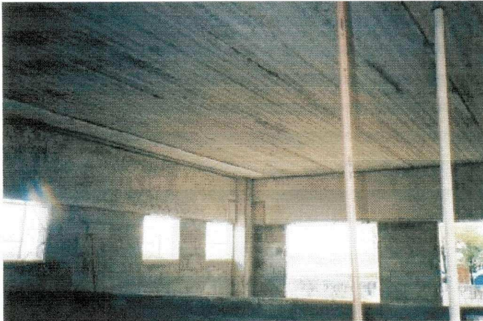
Figura 5 – Detalhe da montagem de pilares e vigas pré-moldados
