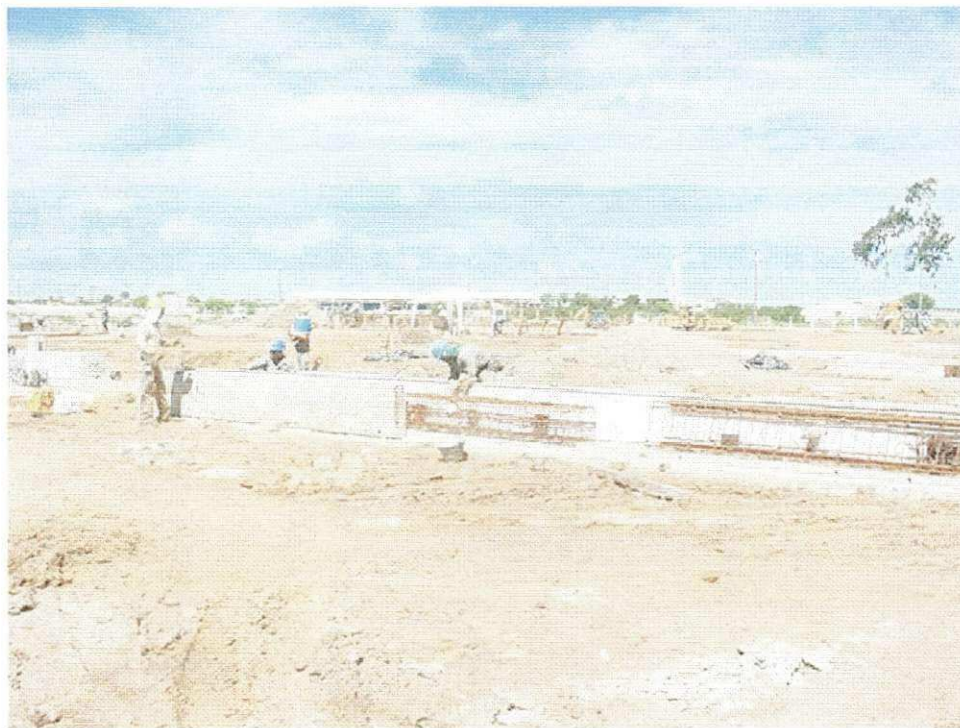
Figura 4 – Fechamento da fôrma de um pilar pré-moldado
