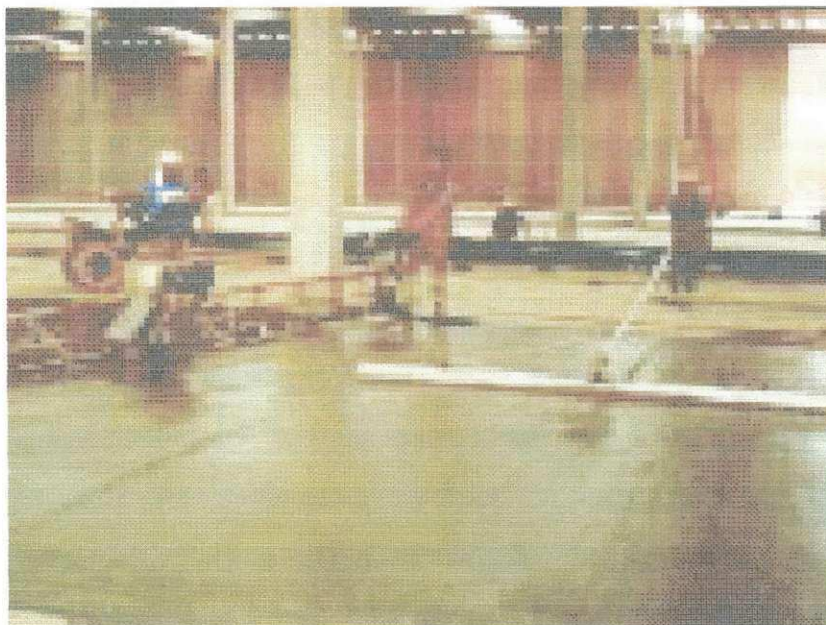
Figura 10 – Regularização da superfície utilizando o “rodo de corte”.
