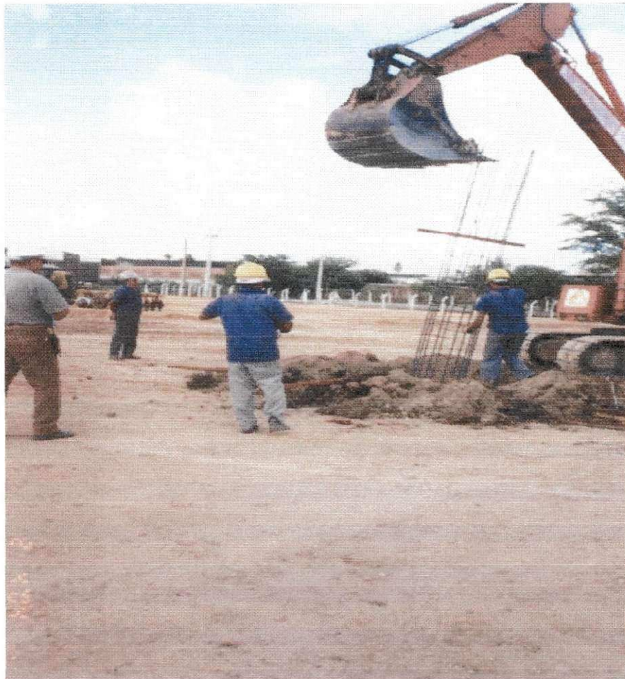
Figura 1 – Posicionamento da armadura com auxílio mecânico
