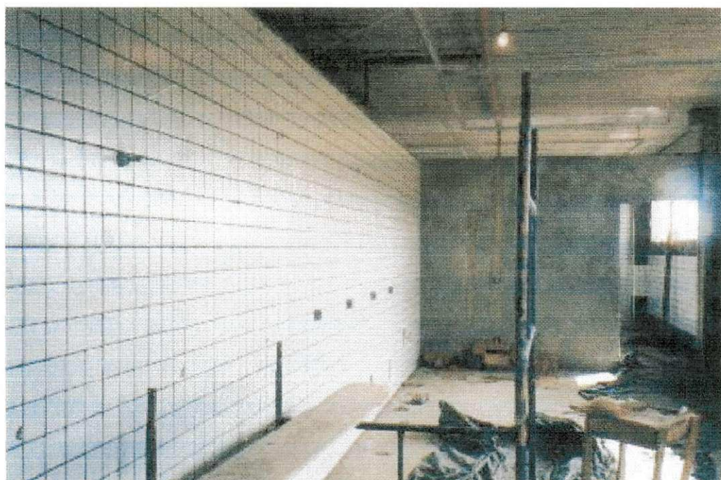
Figura 6 – Revestimento das paredes com cerâmica
