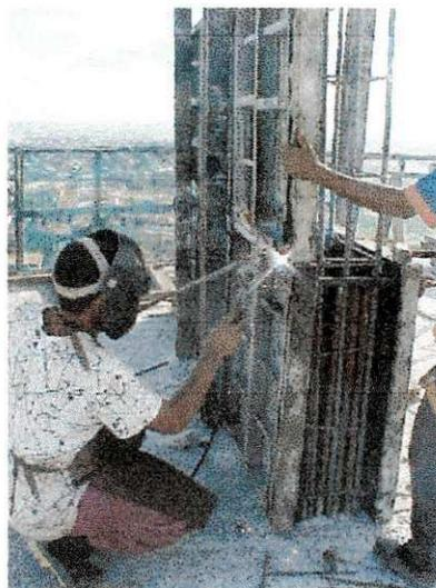
Foto 25 (observa-se o dobramento para dentro dos ferros de espera)
