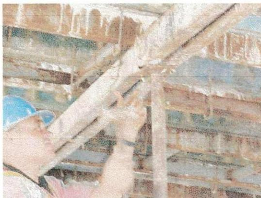
Foto 11 (Retirada dos suportes de sustentação da laje)
