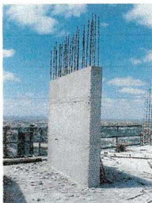
Foto 20 (Pilar depois de retirada a fôrma)
