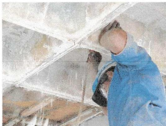
Foto 12 (Retirada das fôrmas da laje)
