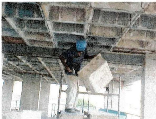
Foto 1 (Fôrma Plástica sendo retirada)
