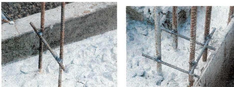
Foto 13, 14 e 15 (solda de pedaços de ferro para garantir com que a fôrma não encoste, garantindo assim um recobrimento perfeito da ferragem)
