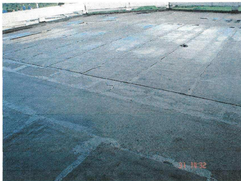
Foto 9 – Impermeabilização com manta asfáltica em duas camadas
