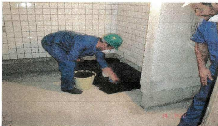
Foto 1- impermeabilização dos banheiros.
