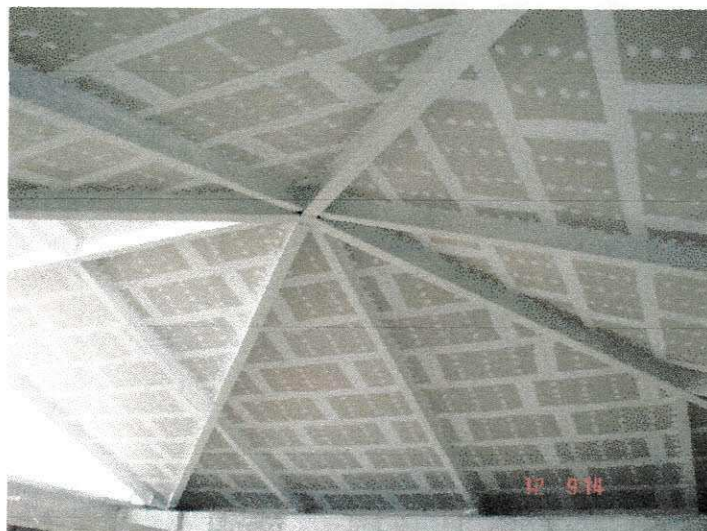
Foto 5 – Cobertura de Gesso Acartonado em estrutura metálica
