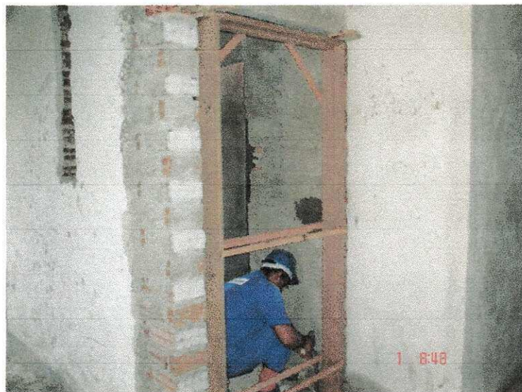
Foto 7 – Sentamento das esquadrias
