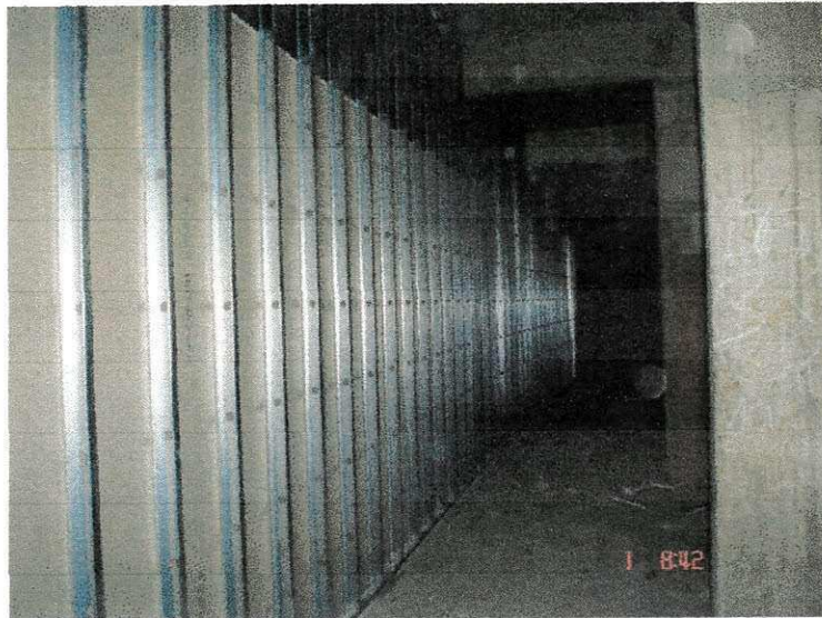
Foto 6 – Parede de Dry Wall mostrando as estruturas metálicas que dão sustentação ao gesso acartonado.
