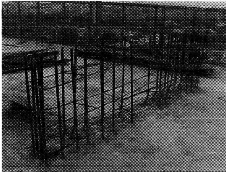
Figura 4 – Ferro de Espera dos Pilares
