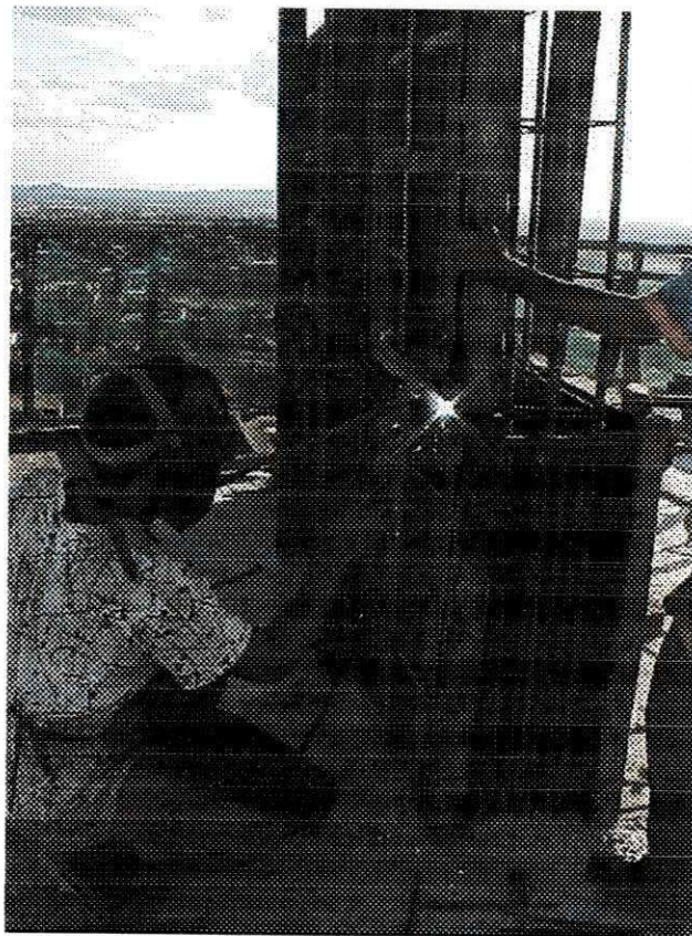
Figura 6 – Colocação das fôrmas dos pilares
