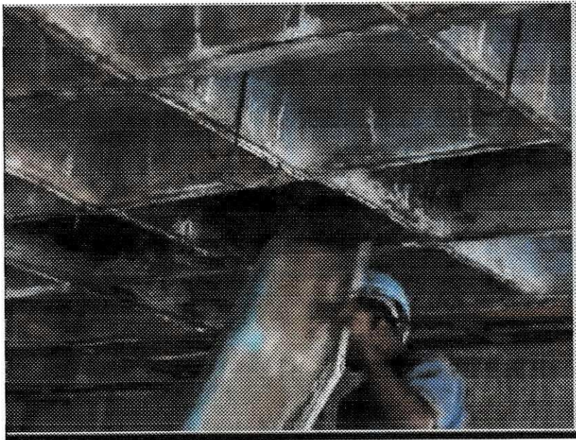
Figura 7 – Concretagem dos pilares
