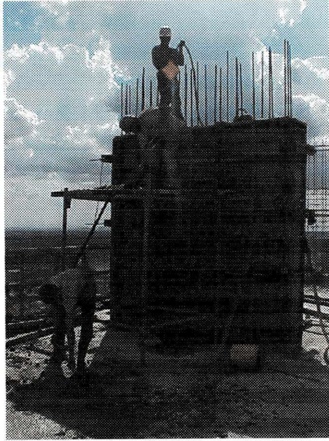
Figura 7 – Concretagem dos pilares
