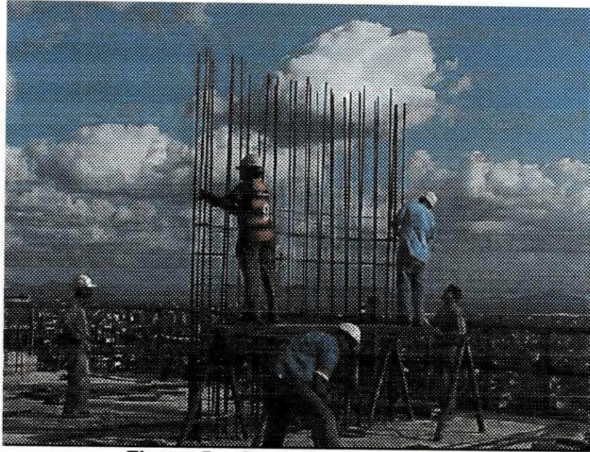
Figura 5 - Armação dos pilares
