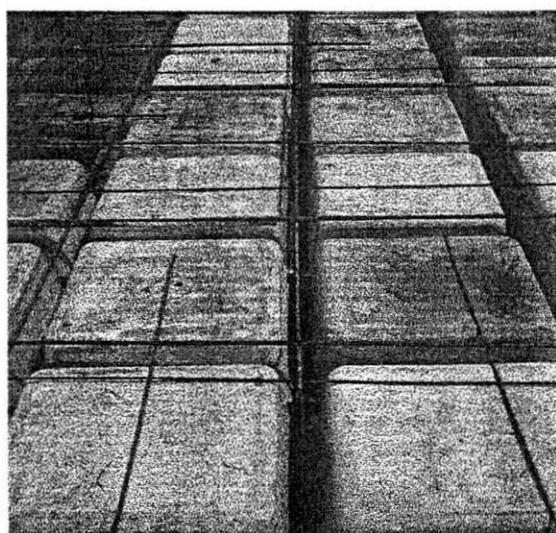
**Figuras 2 e 3.: Lajes Nervuradas**
