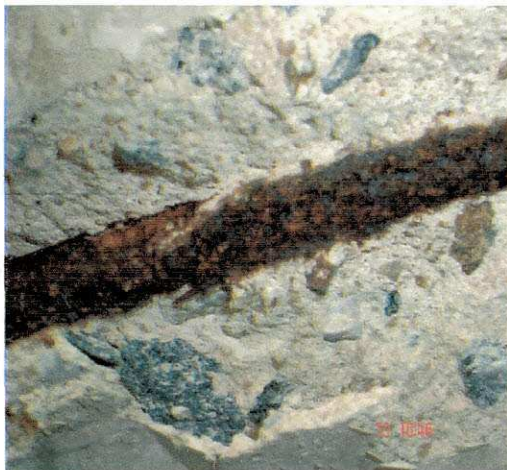
Foto 5 – Corrosão nas armaduras
