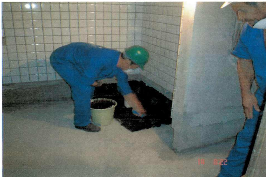
Foto 10 - Impermeabilização dos banheiros com asfalto modificado.
