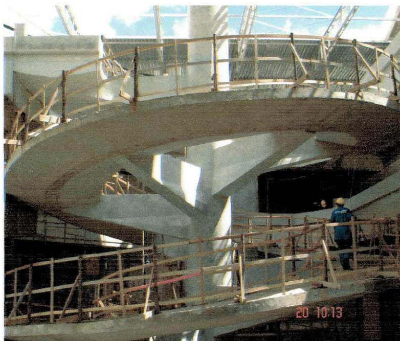
Foto 9 – guarda corpo na rampa helicoidal
