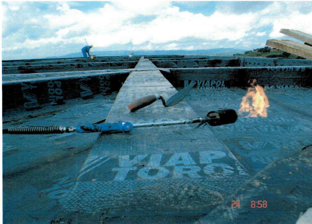
Foto 11 – Impermeabilização de laje com manta asfáltica.
