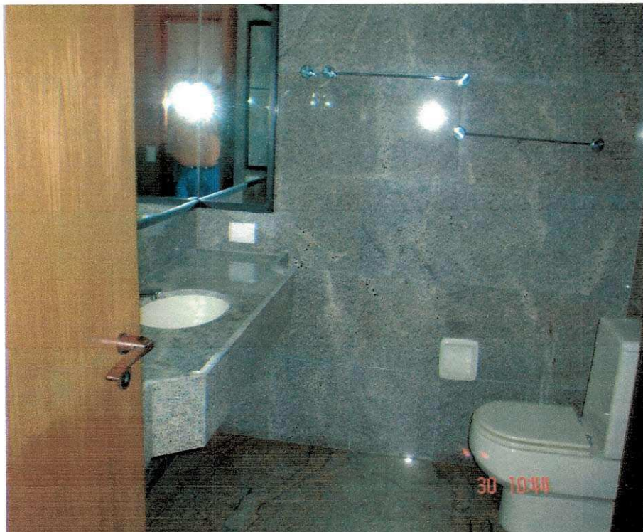
Foto 4 - Banheiros revestidos de granito
