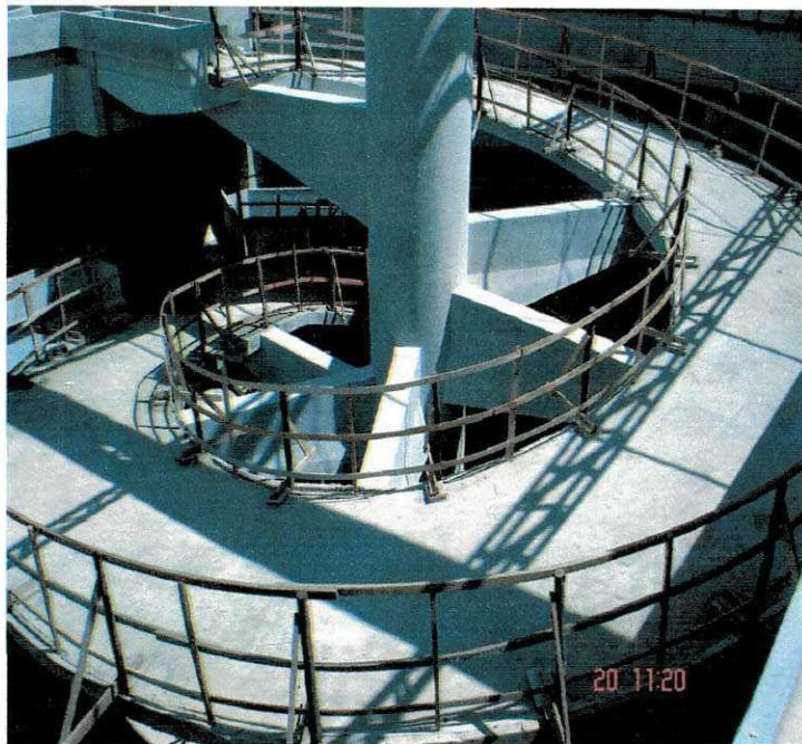
Foto 8 – guarda corpo na rampa helicoidal
