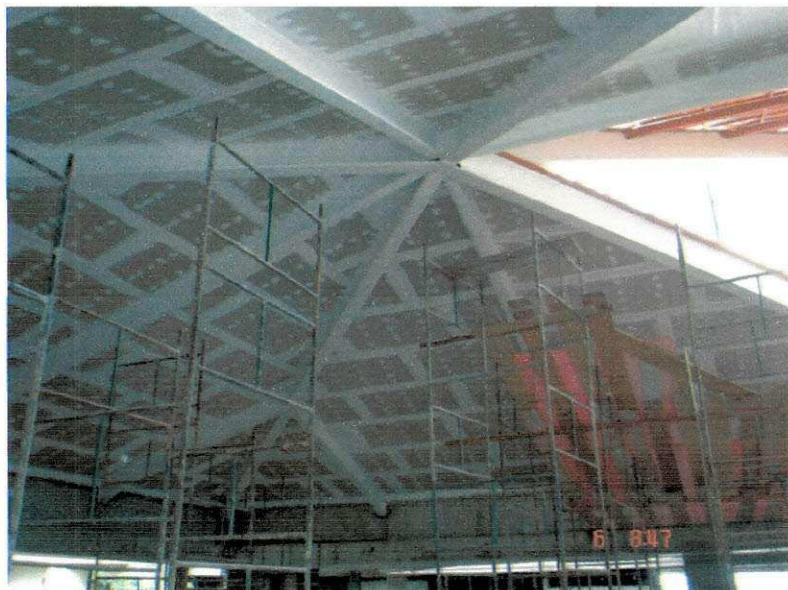
Foto 14 - Gesso acartonado na cobertura do lobby.
