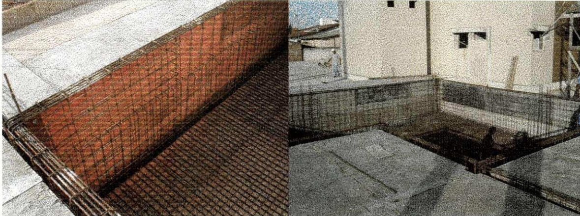
Figura 5.3 e 5.4 - Armadura e lajes da piscina
