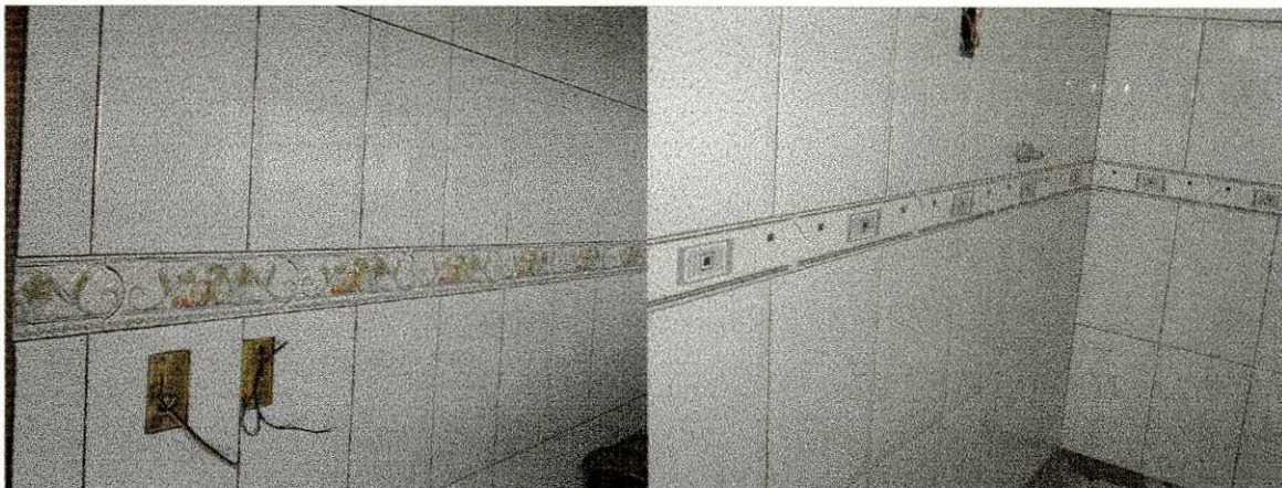
Figura 5.10 e 5.11 – Cerâmica da cozinha e do banheiro
