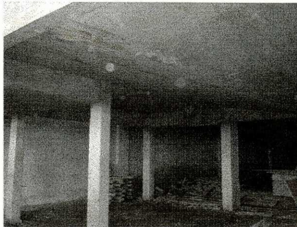
Figura 5.9 – Parte de baixo da piscina
