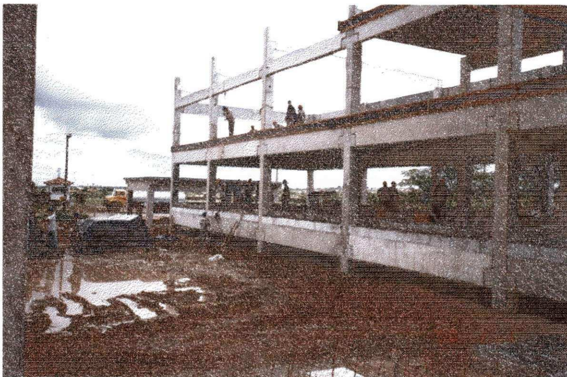
Figura 5 (Montagem de vigas e de lajes)
