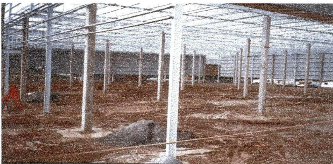
Figura 4 (Pilares de concreto e pilares metálicos)
