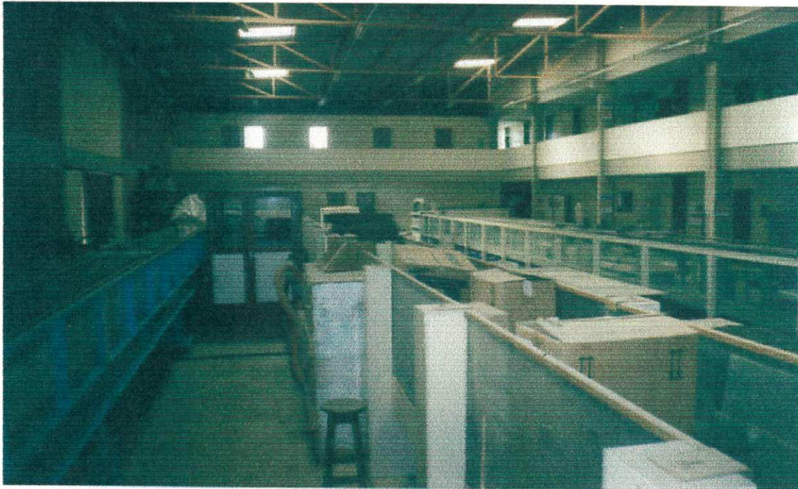
FOTO 01 – NESTA IMAGEM VÊ-SE OS TRÊS CANAIS DO LABORATÓRIO I. O DO CENTRO NÃO DISPÕE DE CANALIZAÇÃO QUE O ABASTEÇA, PORTANTO ESTÁ SEM USO. ATUALMENTE É USANDO APENAS PARA DEPÓSITO DE CAIXAS E OUTROS MATERIAIS. ESTE CANAL É FEITO DE ALVENARIA, AÇO E VIDRO. TANTO O AÇO QUANTO O VIDRO PODEM SER REAPROVEITADOS PARA CONFEÇÃO DO APOI PARA AS ESTUFAS E PARA A CONSTRUÇÃO DOS AMBIENTES DE ESPOSIÇÃO DOS TRABALHOS QUE SE REALIZAM NO LABORATÓRIO, ALÉM DA CONSTRUÇÃO DOS QUATRO BOXES PARA REALIZAÇÃO DOS EXPERIMENTOS DE HIDRÁULICA QUE SERÃO LOCALIZADOS NO LOCAL OCUPADO PELO CANAL, QUANDO ESTE FOR DEMOLIDO.
