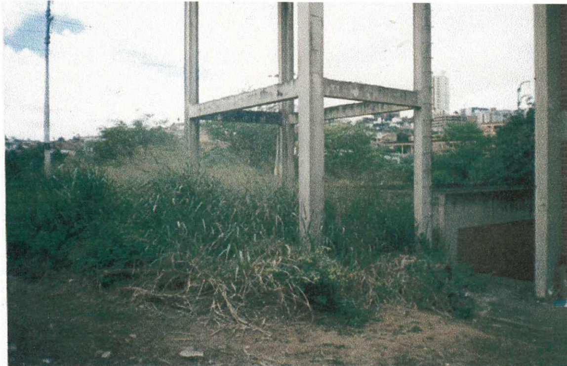
FOTO 05 – COLUNAS DA CAIXA D'ÁGUA CONSTRUÍDA FORA DO LABORATÓRIO E ATÉ HOJE SEM USO POR FALTA DE TUBULAÇÃO. A PROPOSTA É USAR O ESPAÇO ENTRE AS COLUNAS PARA CONSTRUÇÃO DE UMA OFICINA QUE PODERIA ABRIGAR TANTO O COMPRESSOR QUE HOJE FICA DENTRO DO LABORATÓRIO, QUANTO AS FERRAMENTAS E OUTROS OBJETOS DO LABORATÓRIO.
