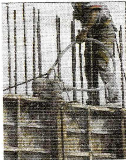
Concretagem dos pilares
