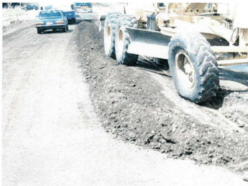
Figura 12: Patrol reabrindo o trecho.
