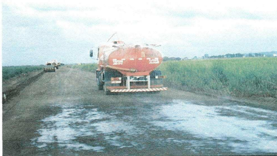
Figura 5: Caminhão pipa molhando o trecho.
