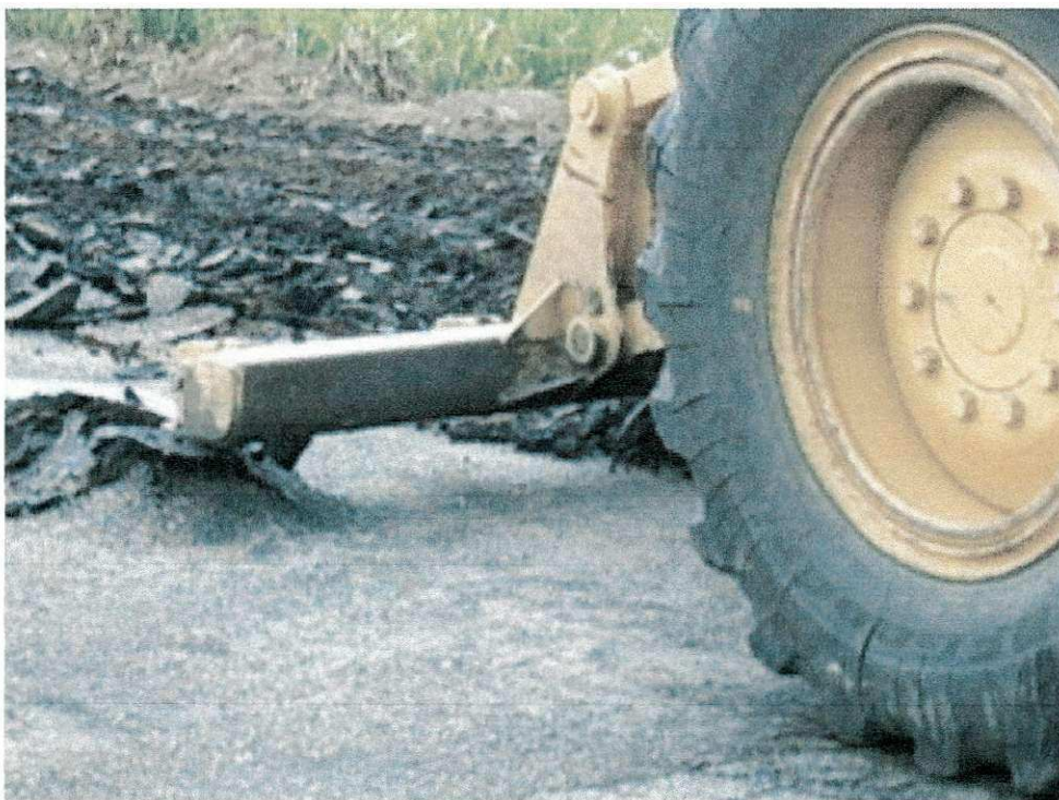
Figura 2: Escarificação da estrada antiga.
