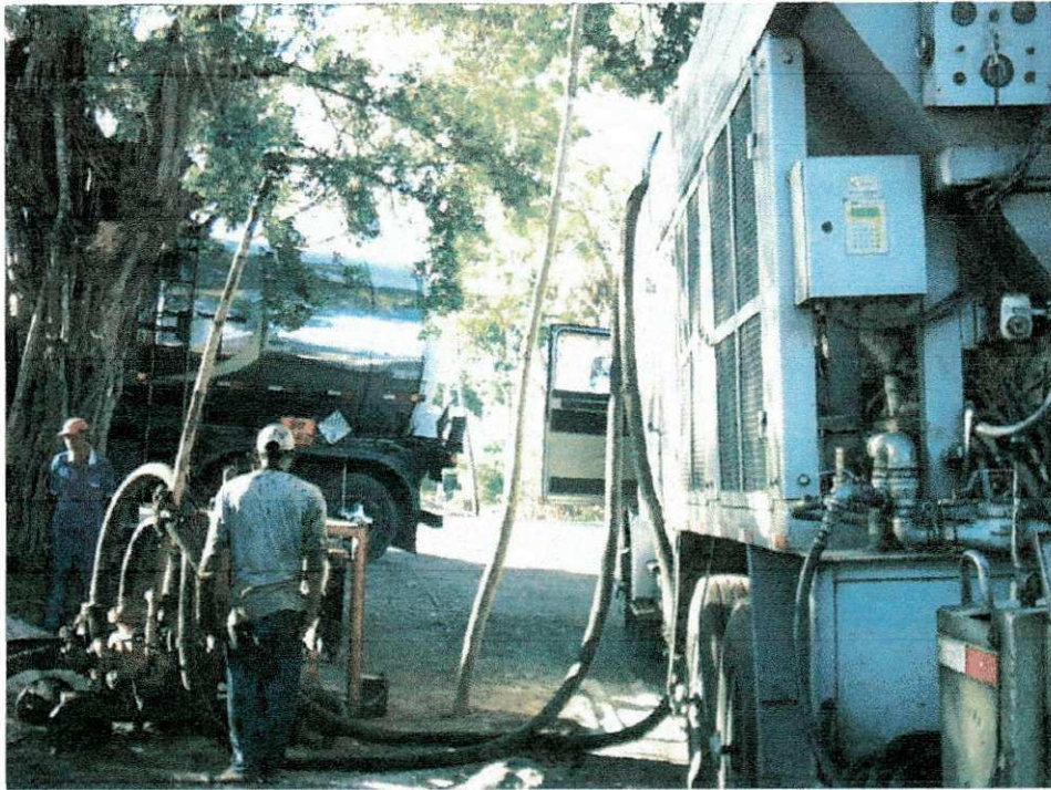
Figura 20: Carregando a usina de micro revestimento com água.
