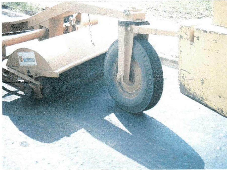
Figura 17: Vassoura mecânica varrendo a base imprimada.
