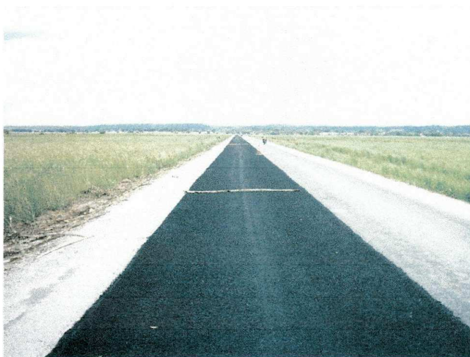
Figura 28: Micro revestimento aplicado em uma faixa de rolamento.
