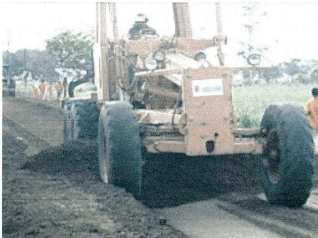
Figura 4: Execução da base.
