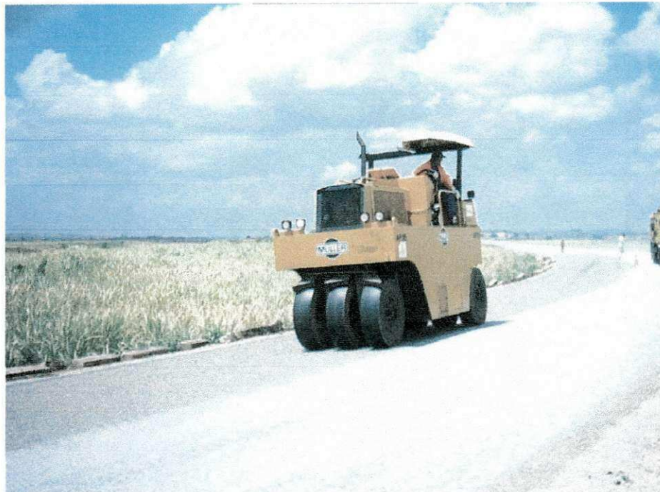
Figura 18: Rolo de pneus compactando o tratamento superficial simples.
