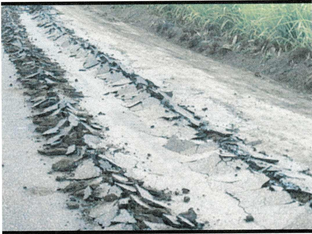
Figura 3: Estrada sendo escarificada.
