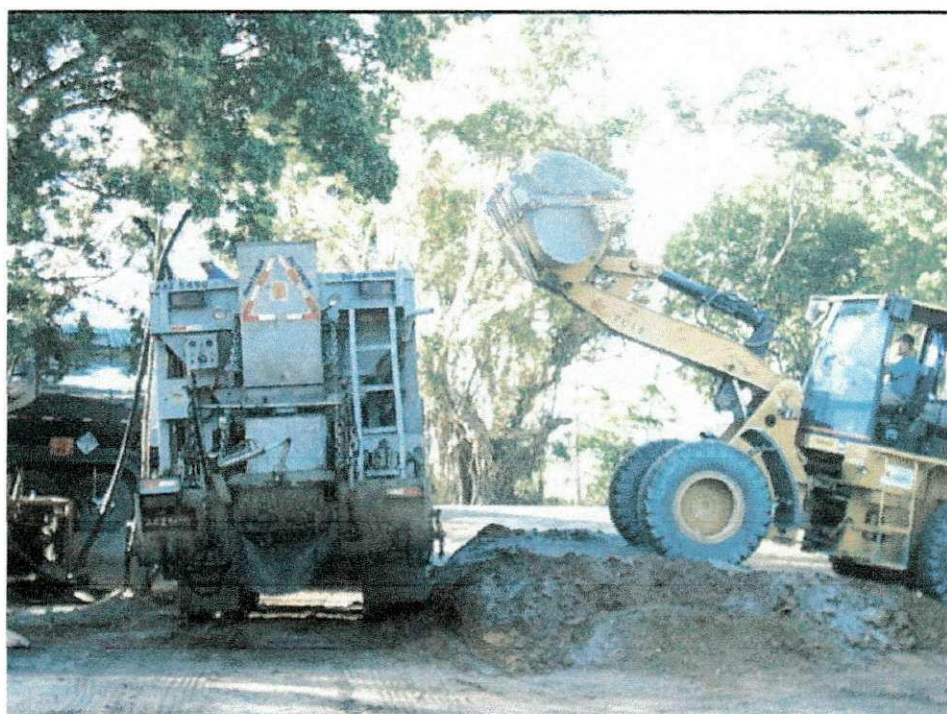
Figura 19: carregando a usina de micro com pó de pedra.
