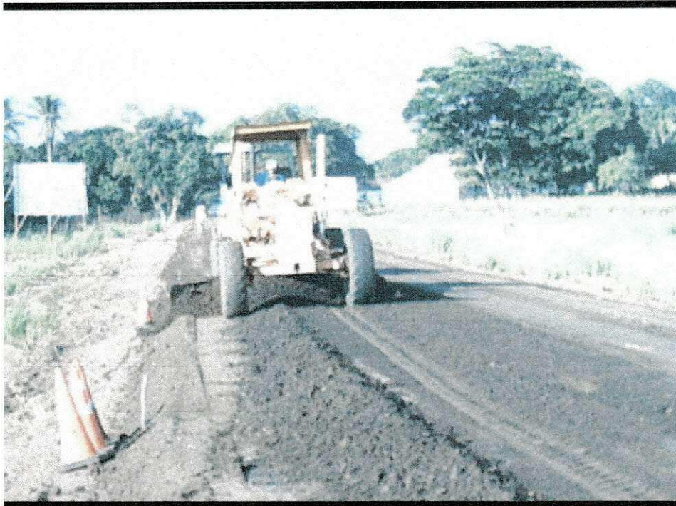
Figura 8: Patrol cortando piquetes.
