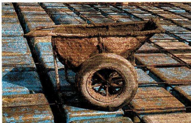
figura 11 - Jerica para transporte do concreto
