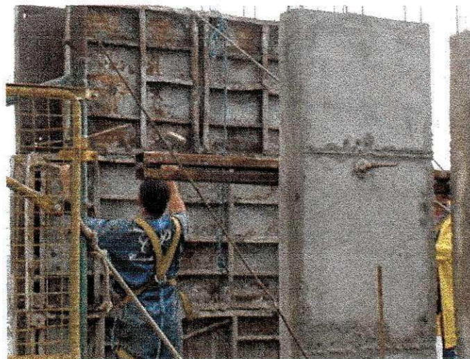
Figura 10 - Retirada da fôrma das faces do pilar.
