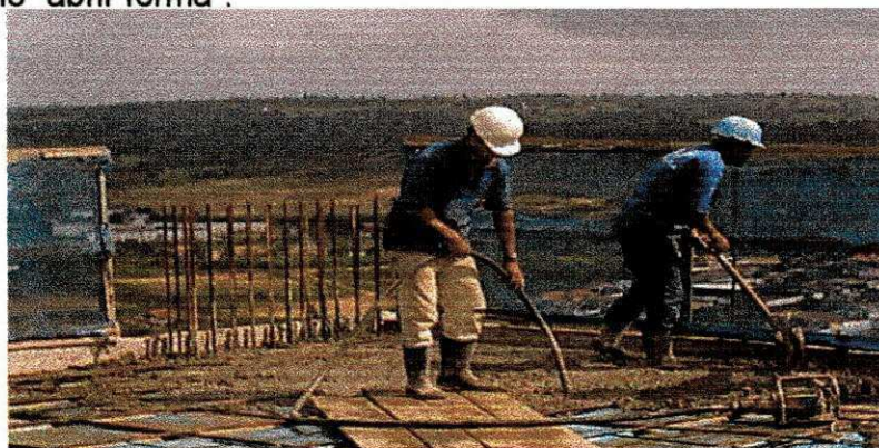
figura 9 – Adensamento do concreto
