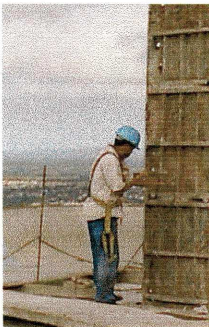
figura 13 - Trabalhador utilizando EPI
