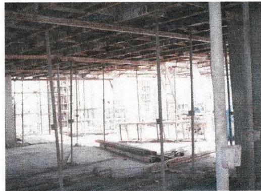
Figura 19 - Escoramentos metálicos verticais.
