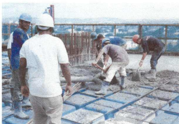
Figura 9 - Lançamento do concreto usinado.
