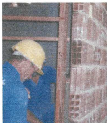
Figura 26 - Colocação das forras.
