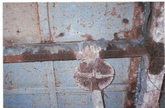
Figura 20 - Fôrmas metálicas para concreto.
