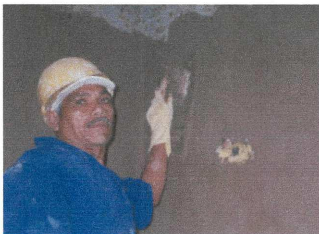
Figura 28 - Reboco interno.
