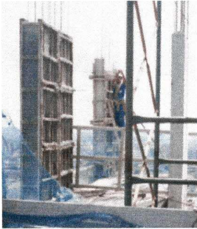
Figura 15 - Retirada das fôrmas.
