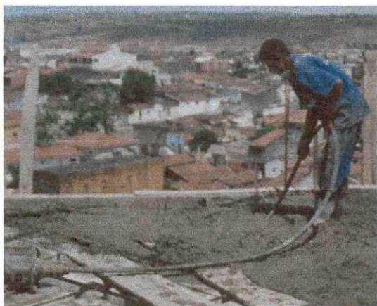
Figura 11 - Operário vibrando o concreto.
