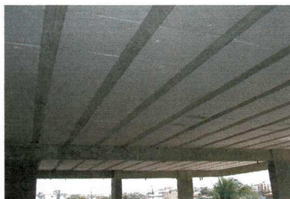
Figura 30 - Laje nervurada com blocos de EPS.
