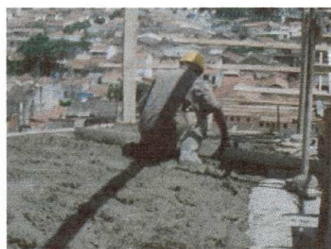
Figura 12 - Nivelamento do concreto.
