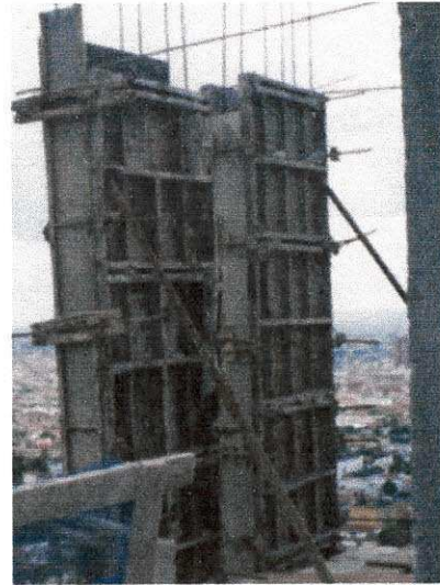
Figura 18 - Armadura à espera do concreto usinado.
