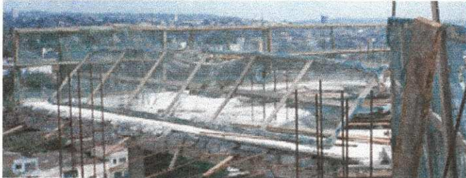
Figura 21 - Tela de proteção.
