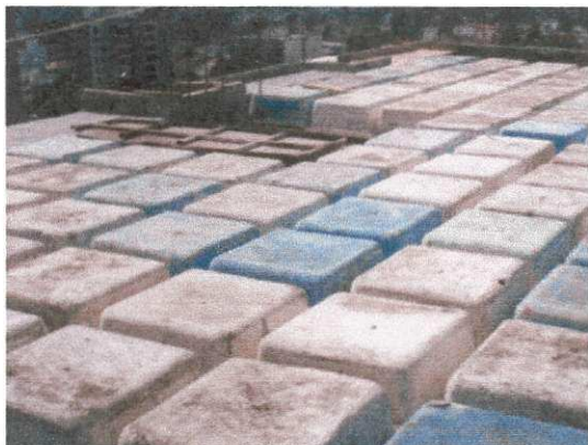
Figura 13 - Laje nervurada antes da concretagem.
