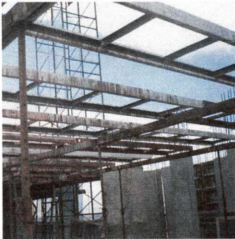
Figura 16 - Escoramentos horizontais.
