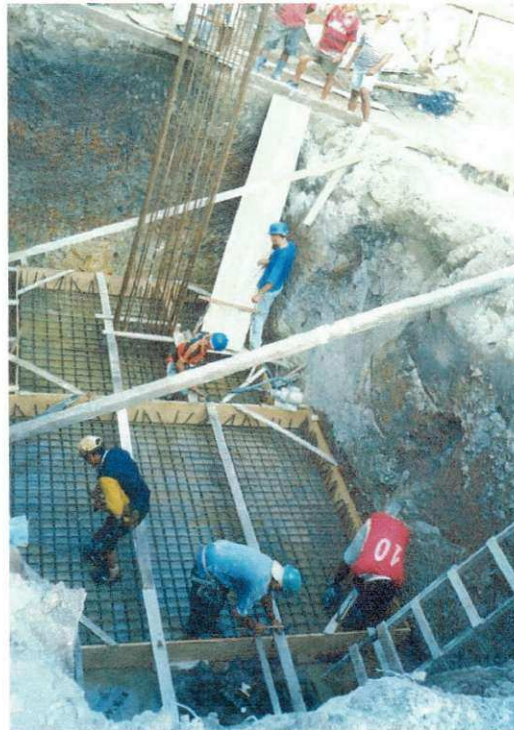
Armação da sapata.
