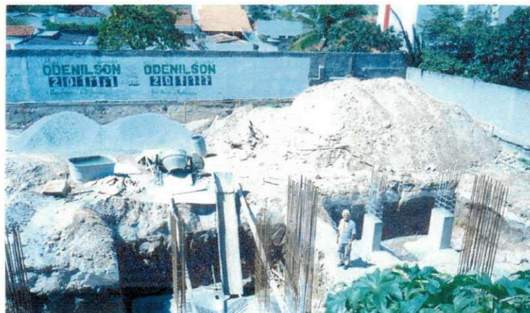
Sapatas concretadas.
