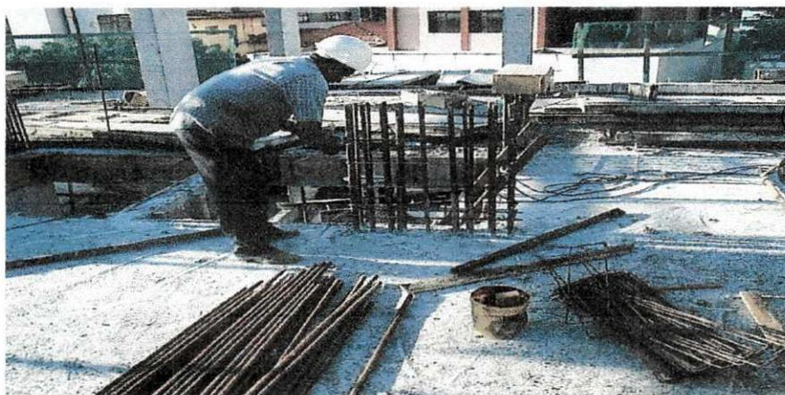
**Foto 2: Armadura dos pilares**
