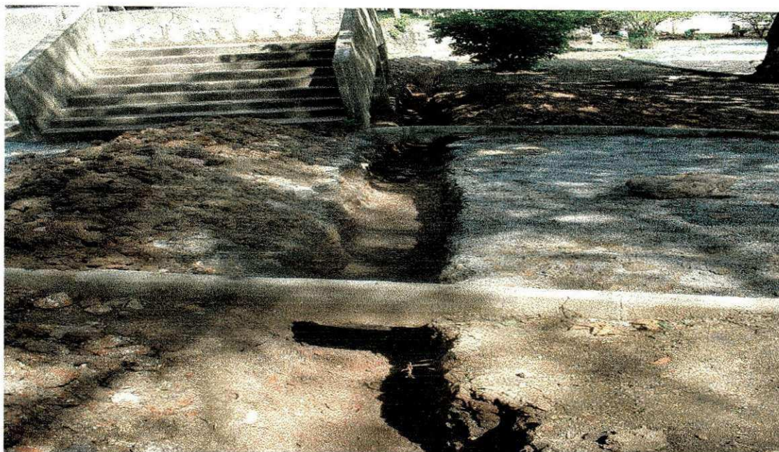
Figura 03 - escavação rasa pois não há tráfego
