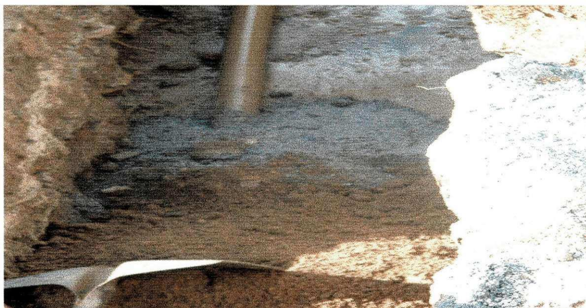
Figura 04 - escavação e assentamento de tubos
