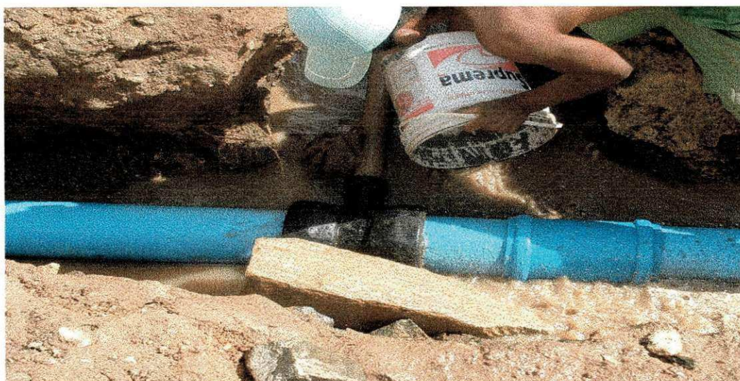
Figura 05 - utilização de "T" com redução
