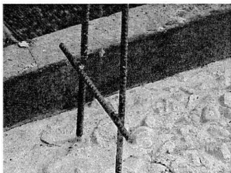
Foto 13, 14 e 15 (solda de pedaços de ferro para garantir com que a fôrma não encoste, garantindo assim um recobrimento perfeito da ferragem)
