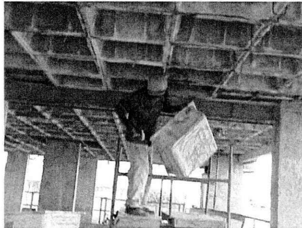
Foto 1 (Fôrma Plástica sendo retirada)
