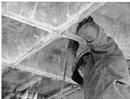
Foto 12 (Retirada das fôrmas da laje)
