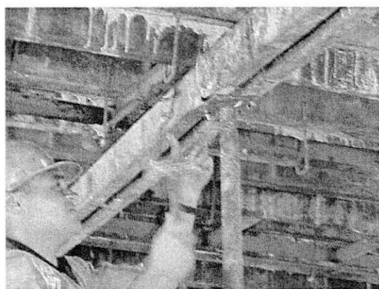
Foto 11 (Retirada dos suportes de sustentação da laje)
