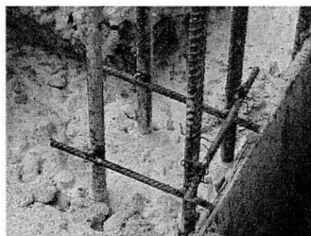
Foto 13, 14 e 15 (solda de pedaços de ferro para garantir com que a fôrma não encoste, garantindo assim um recobrimento perfeito da ferragem)
