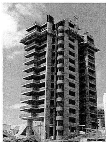
Foto 16 (observa-se a estrutura de fechamento)
