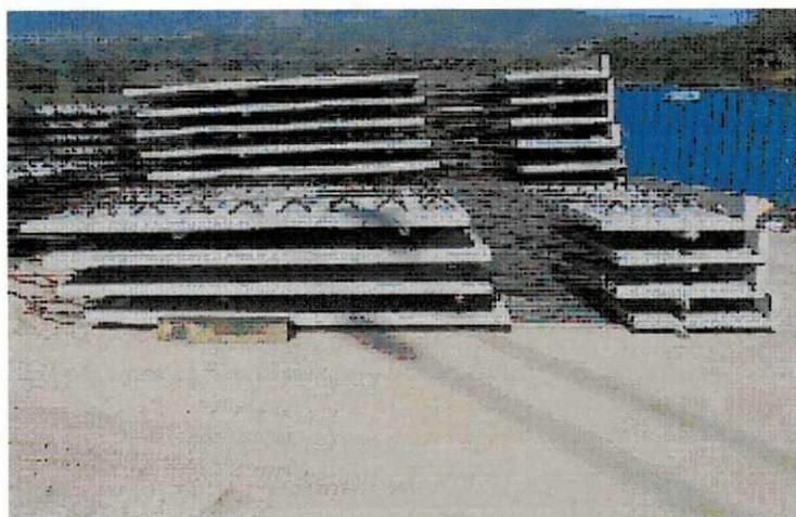
*Figura 8 – exemplos de pré-lajes utilizadas em obra*
