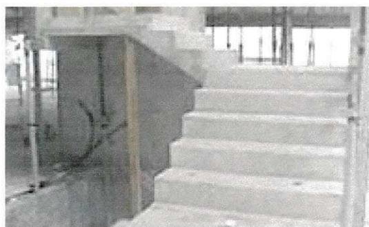
Figura 22 – escada pré-moldada depois de ser instalada
