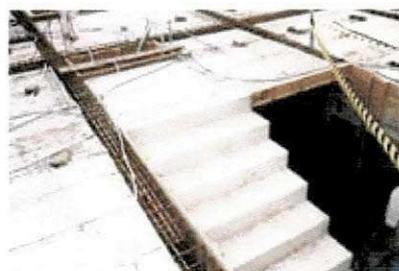
Figura 23 – escada pré-moldada antes e depois de ser instalada
