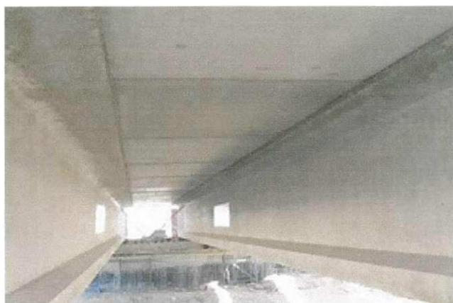
*Figura 7 – pormenor da pré-laje funcionando com cofragem*
