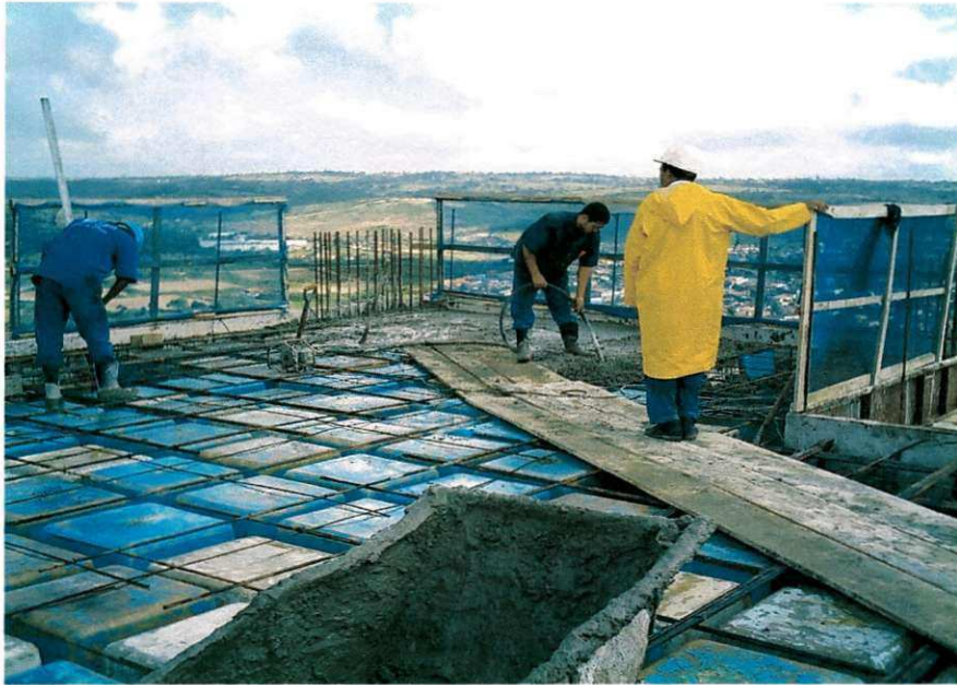
figura 6 – Adensamento do concreto
