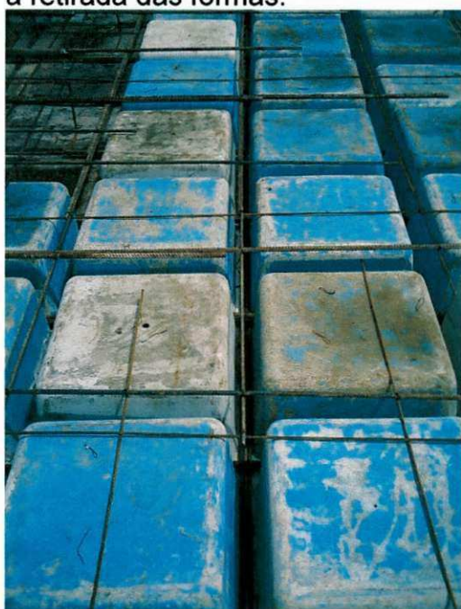
Figura 12 – Detalhe das formas
