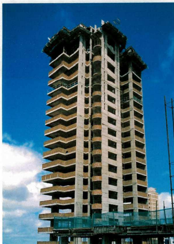
Figura 4 – Encunhamento das paredes a uma altura de 1,5 m
