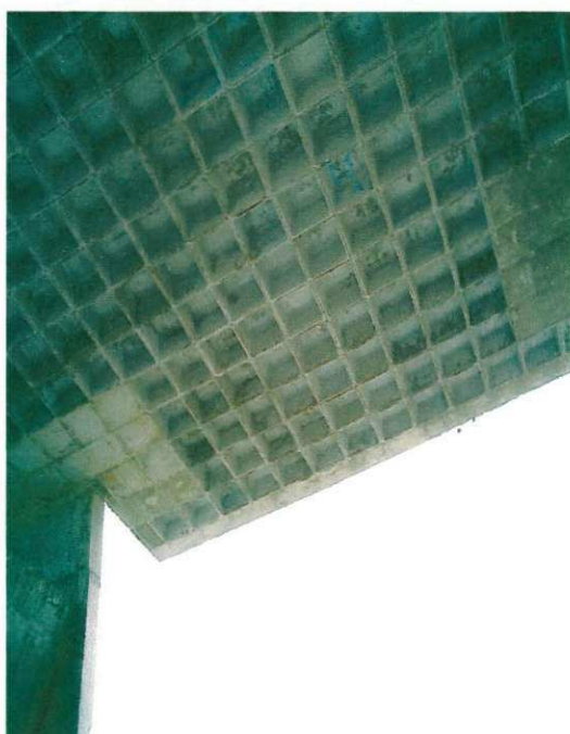
Figura 13 – Detalhe da laje nervurada
