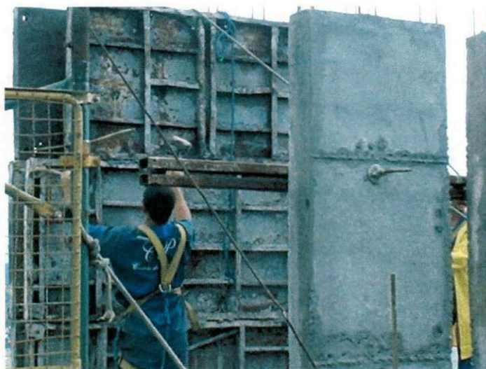
Figura 11 - Retirada da fôrma das faces do pilar
