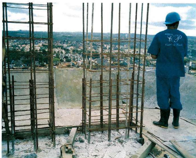
figura 7 – Armação do pilar
