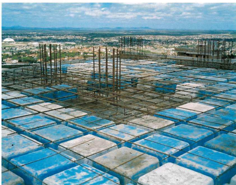
Figura 3 – laje maciça em volta dos pilares
