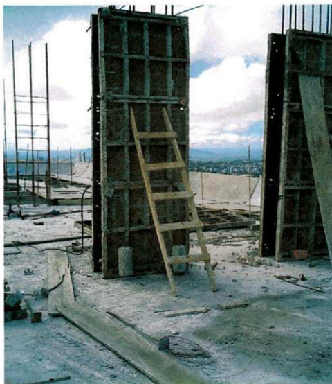
Figura 10 – Fôrma das faces do pilar
