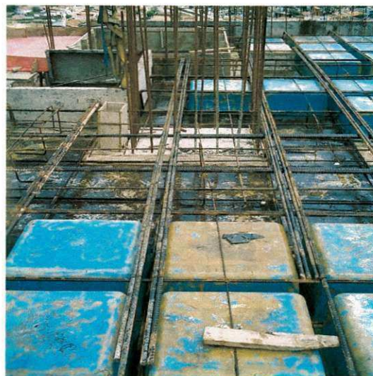
figura 8 – Armação da armadura laje
