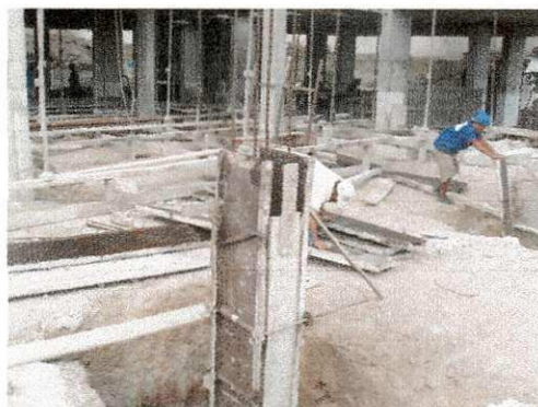
Foto 10, 11 e 12 (solda de pedaços de ferro para garantir com que a fôrma não encoste, garantindo assim um recobrimento perfeito da ferragem)
