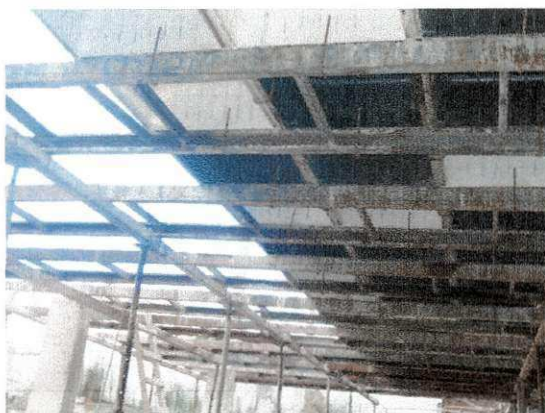
Foto 9 ( Suporte de sustentação das fôrmas )
