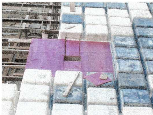
Foto 14 (Fôrmas de polipropileno)
