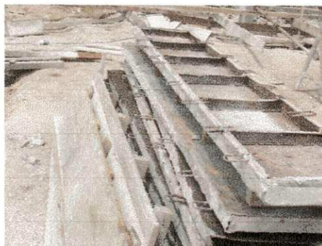
Foto 10, 11 e 12 (solda de pedaços de ferro para garantir com que a fôrma não encoste, garantindo assim um recobrimento perfeito da ferragem)
