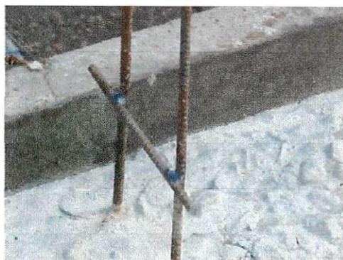
Foto 10, 11 e 12 (solda de pedaços de ferro para garantir com que a fôrma não encoste, garantindo assim um recobrimento perfeito da ferragem)
