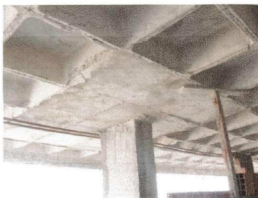
Foto 8 (Encontro da laje nervurada com o pilar)
