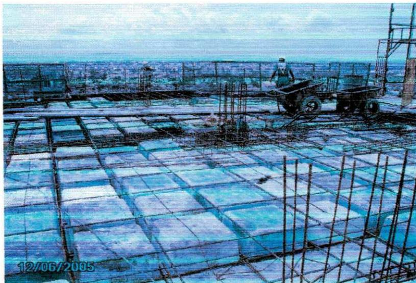
Foto 12 - Disposição da laje nervurada-cogumelo
