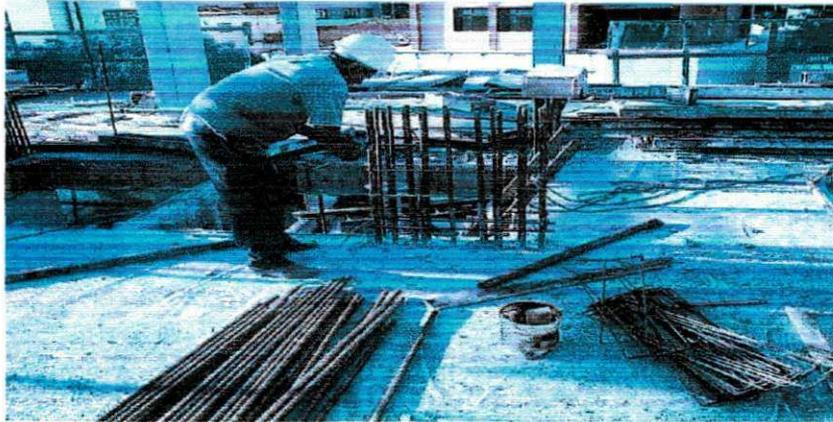
Foto 04: Armadura dos pilares
