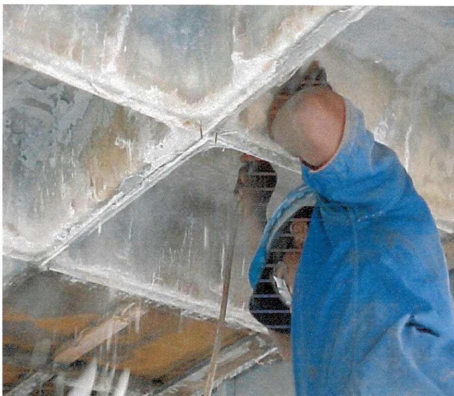
**Figura 3 – Retirada de Fôrma das Lajes**
