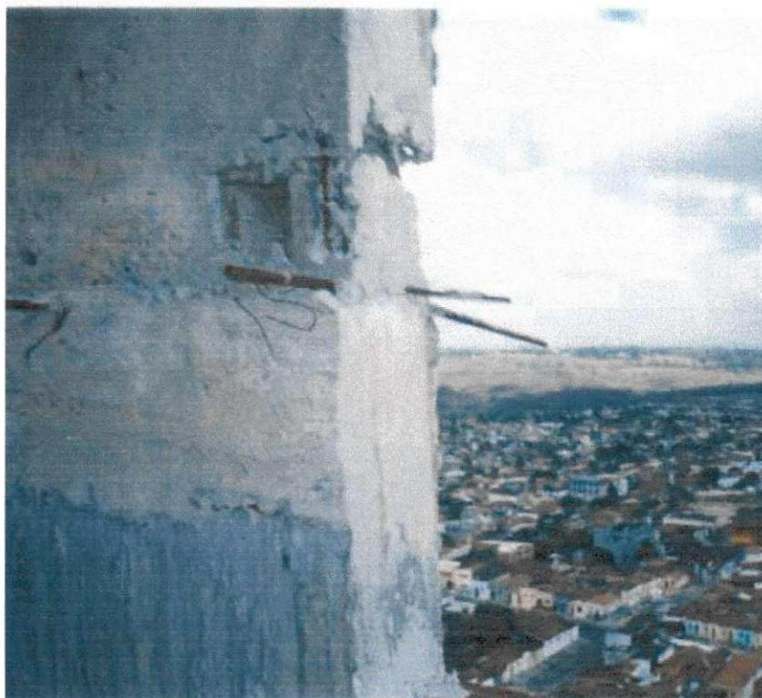
Figura 5 – Pilar com Ferragem Exposta
