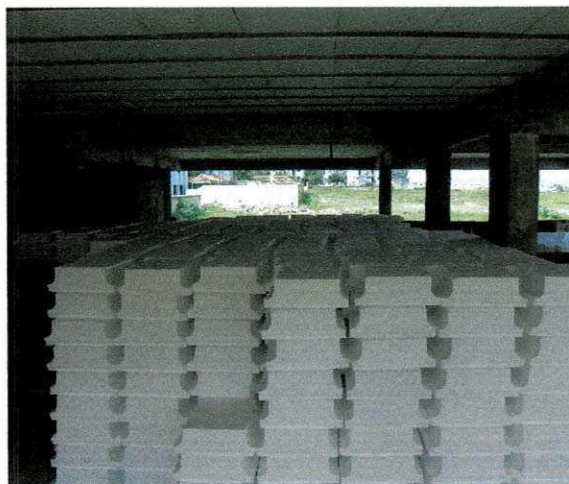
Figura 8 – Armazenamento dos elementos de enchimento (EPS)
