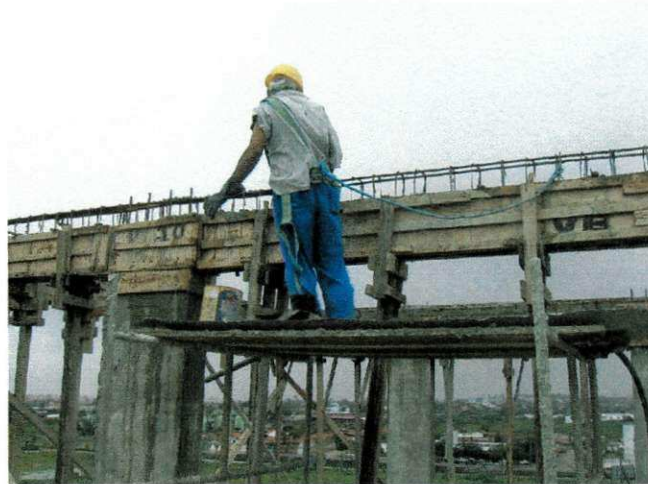
Figura 13 - Trabalhador usando equipamentos de proteção: cinto, luvas e capacete.
