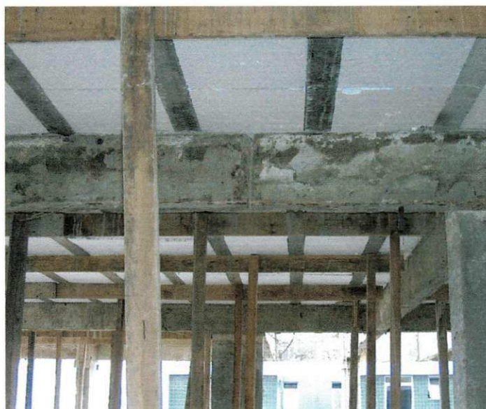
Figura 6 – Escoramento da laje treliçada realizada na obra
