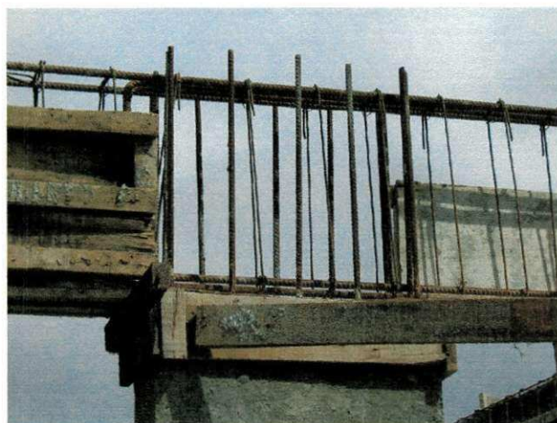
Figura 12 – Transpasse de pilares com vigas
