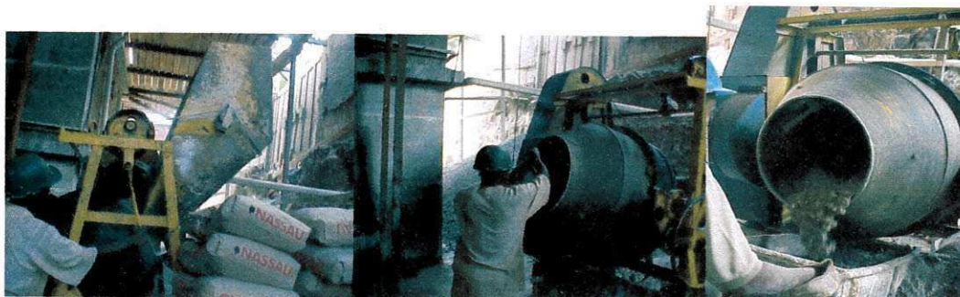
Foto 02 (Processo de produção do concreto in-locu)
