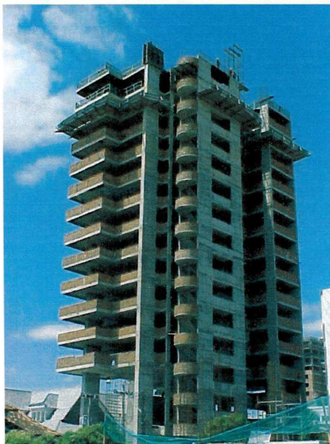
Foto 01 ( Edifício Castelo da Prata)
