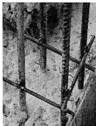
Foto 05e 06 (solda de pedaços de ferro para garantir o recobrimento das ferragens)
