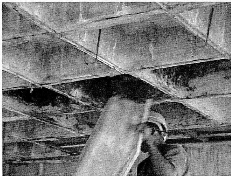
Foto 10 ( desforma de uma laje nervurada)
