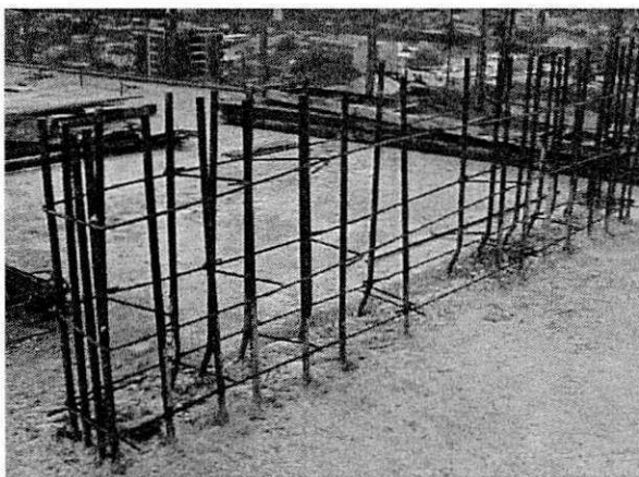
Foto 05e 06 (solda de pedaços de ferro para garantir o recobrimento das ferragens)
