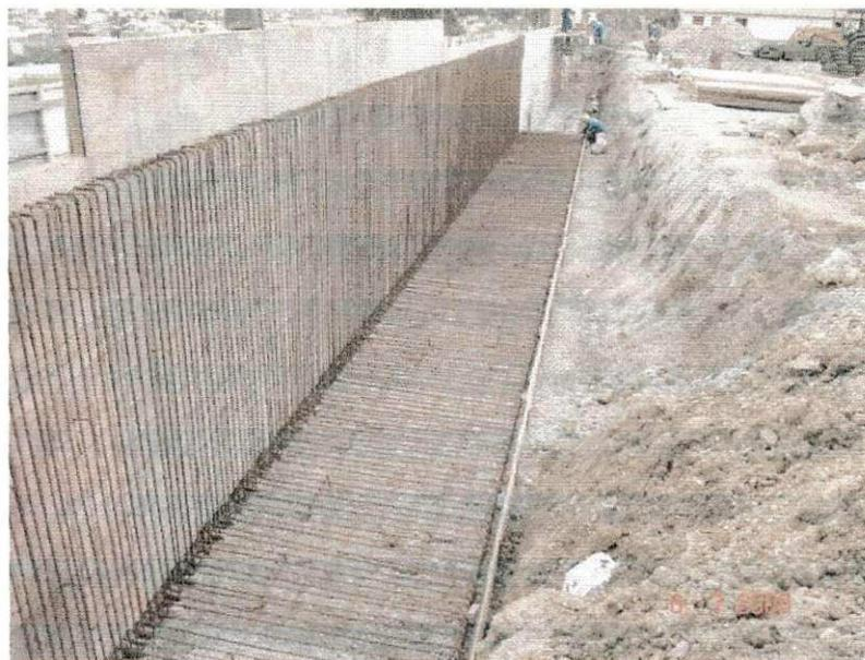
**Figura 12 - Posicionamento e verificação da armadura no muro de arrimo**
