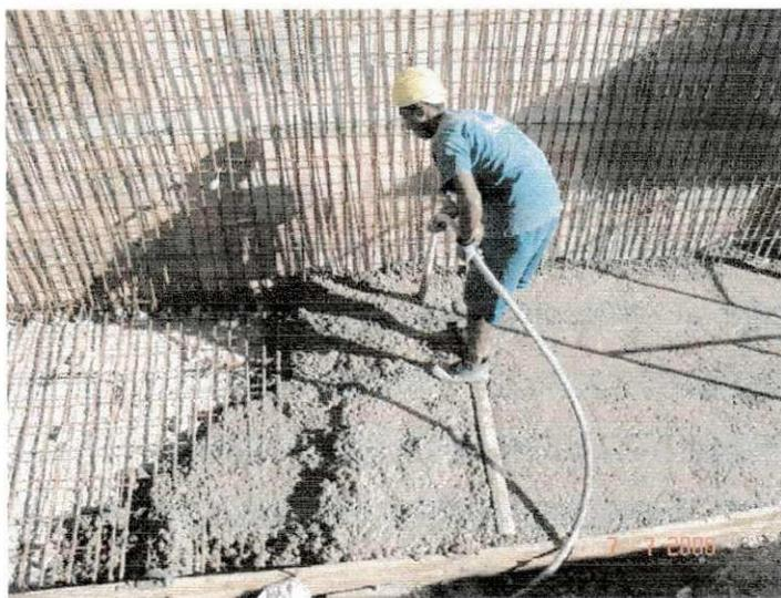
**Figura 14 - Adensamento do concreto através da utilização de vibrador de imersão**
