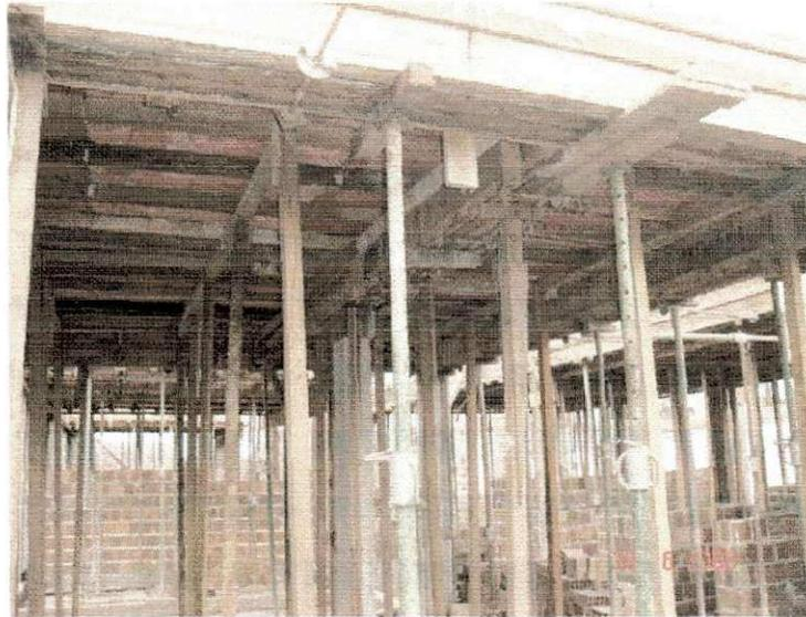
**Figura 11 - Escoramento de laje com uso misto de escoras metálicas e pontaletes**
