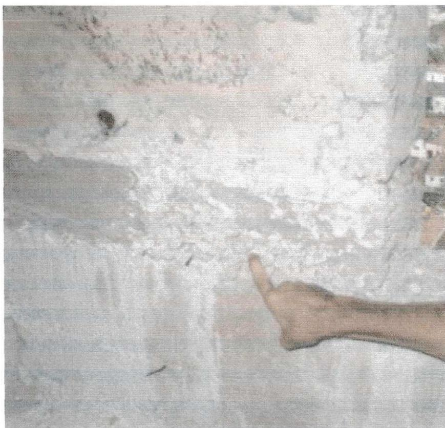
**Figura 16. Agregados graúdos não envolvidos na pasta de cimento e areia.**
