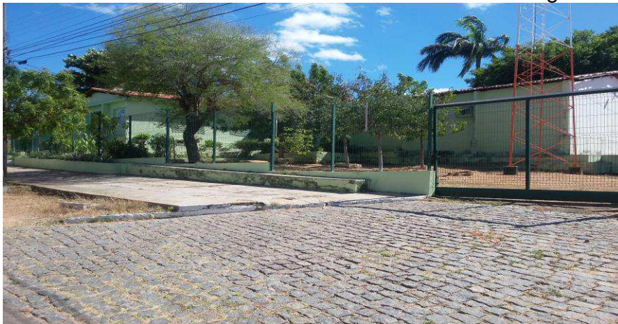
Figura 05: Escola de Ensino Fundamental e Médio Alda Férrer Augusto Dutra.
