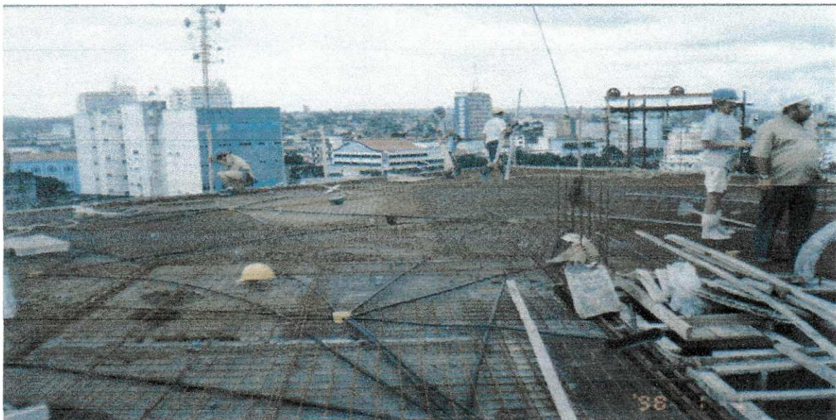
Foto 2 – Detalhe da armadura negativa e positiva da laje
