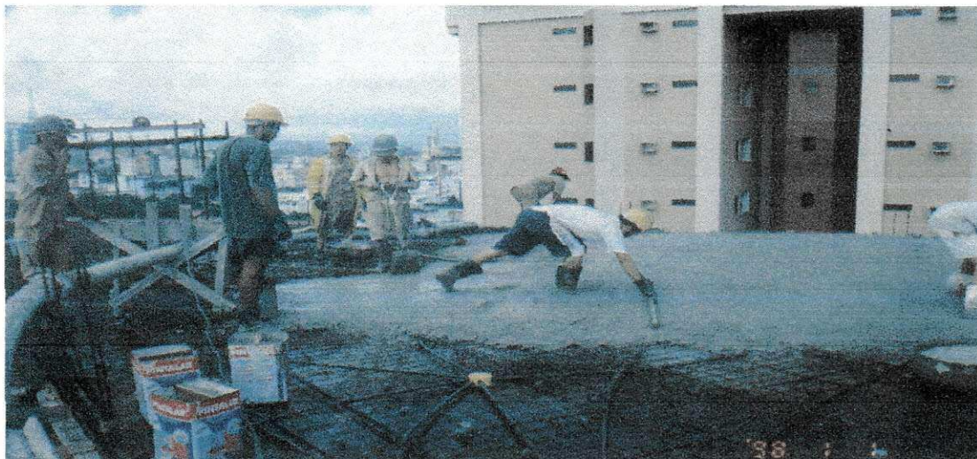
Figura 01.Lançamento de concreto
