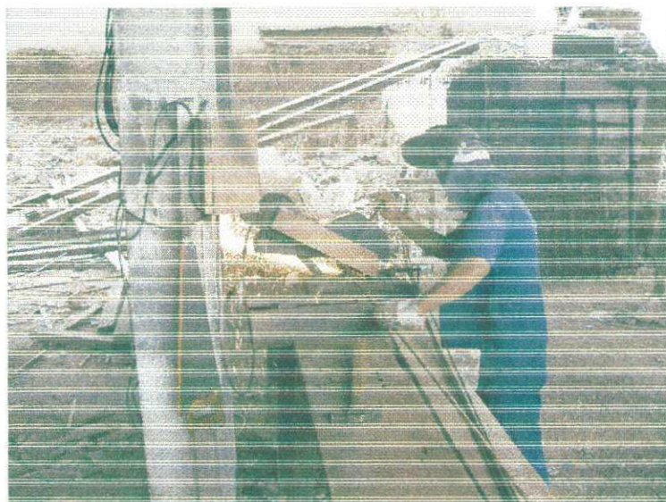
Figura 11 – Corte dos Ferros
