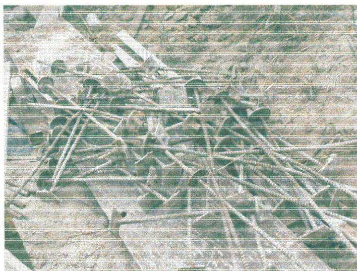
Figura 20 - Dispositiva de encaixe das fôrmas da obra
