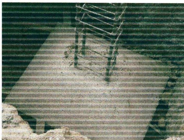
Figura 32 – Sapata pronta
