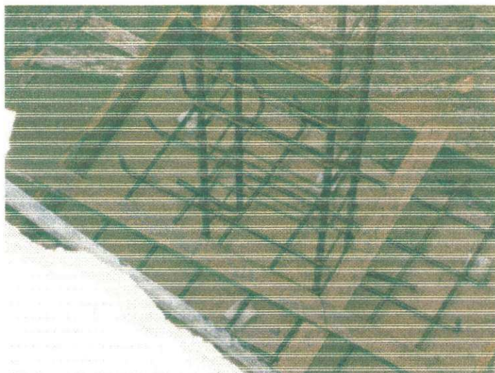
Figura 12 – Ferros do Pilar e da Sapata
