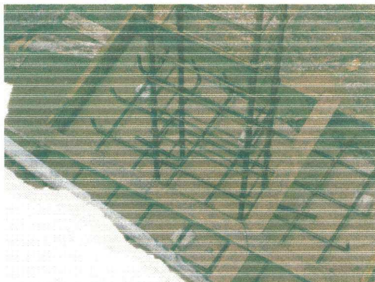
Figura 29 – Grelha da sapata
