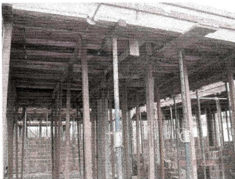
Figura 04 escoramento de laje com uso misto de escoras metálicas e pontaletes
