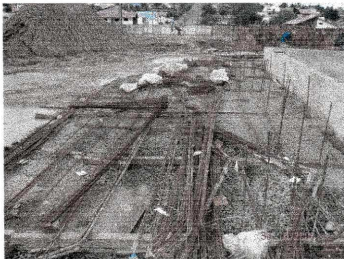
Figura 03. Foto do canteiro de obra observa-se as ferragens apoiadas sobre escoras.
