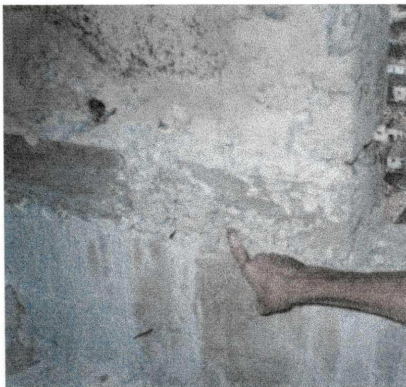
Figura 10. Agregados graúdos não envolvidos na pasta de cimento e areia.
