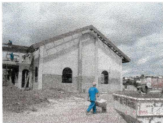
Fig. 12a alvenaria sobre as janelas fechada
