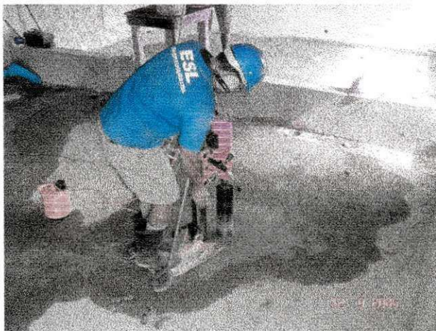
Figura 11 perfuratriz executando furos nas lajes para passagem de eletrodutos.
