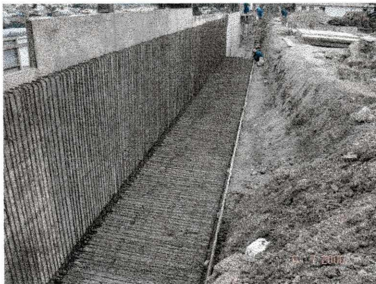
Figura 05 posicionamento e verificação da armadura no muro de arrimo
