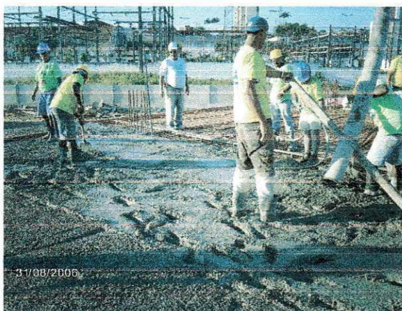
Figura 4-Operários lançando o concreto
