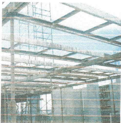
Figura 10 - Escoramentos horizontais.
