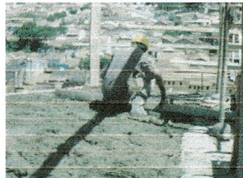
Figura 7-Nivelamento do concreto.
