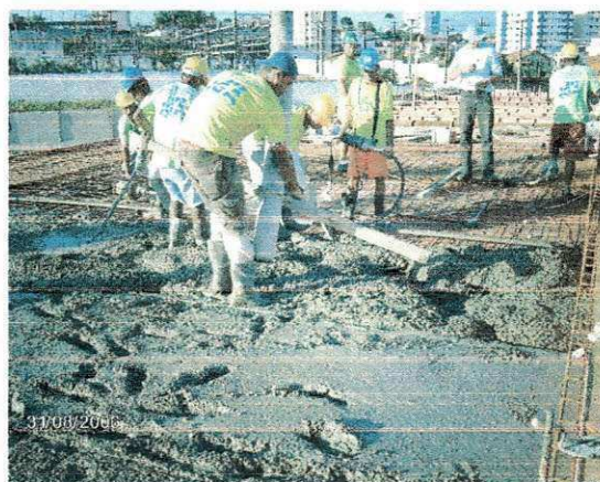
Figura 5-Operários lançando o concreto
