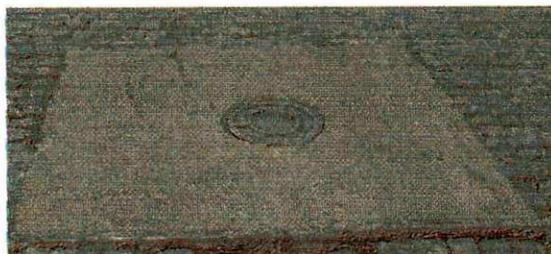
**Figura 42 – Nivelamento do tampão do poço de visita com o pavimento de paralelepípedo através de laje de concreto**
