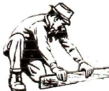
**Figura 36 – Limpeza e regularização do colchão de areia para colocação dos paralelepípedos** [Fonte: DNIT]
