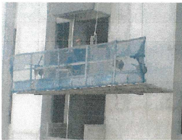
Figura 20. Operários sob plataforma de madeira (jaú).
