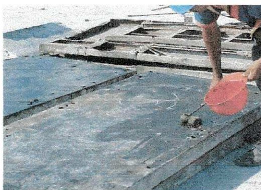
Figuras 23 e 24. Fôrmas de aço dos pilares.
