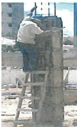
Figura 7. Retirada da fôrma de um pilar.
