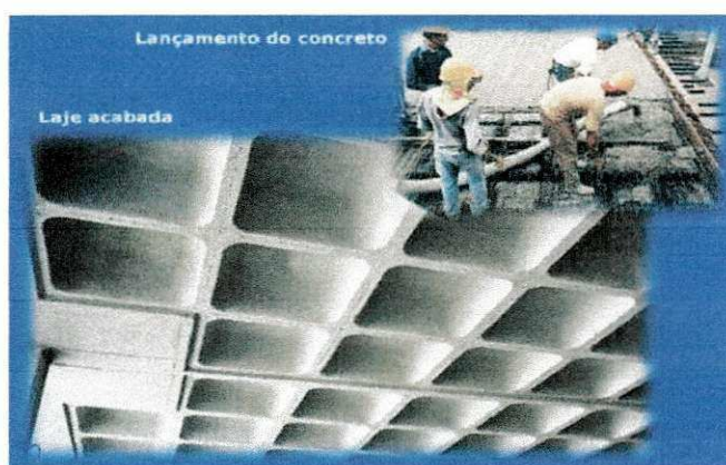
Figura 3. Execução e acabamento da laje nervurada
