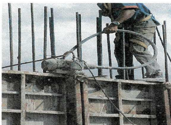
Figura 25. Uso do vibrador de imersão na concretagem de um pilar
