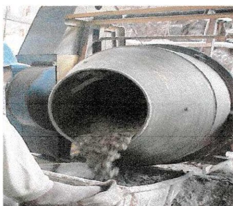
Figura 6. Preparação do Concreto na Betoneira
