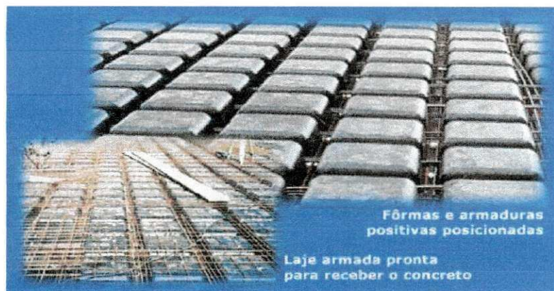
Figura 2. Laje nervurada com fôrmas e armaduras prontas para receber o concreto.
