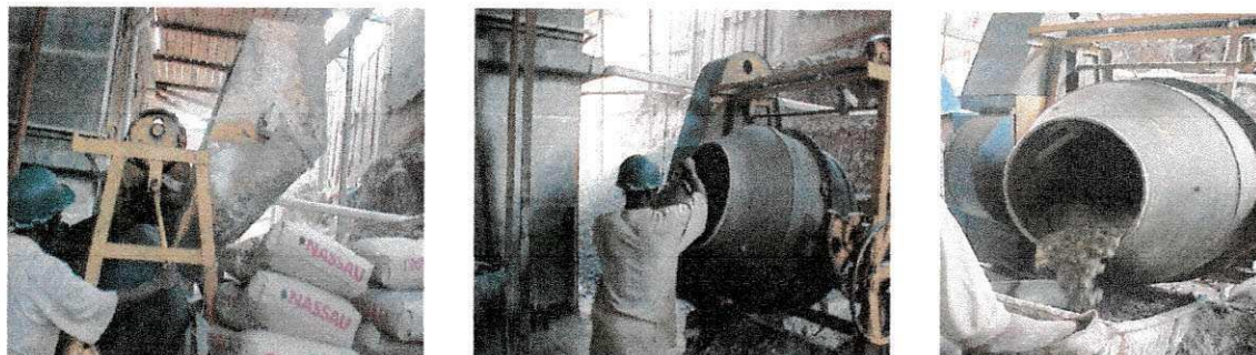
Figuras 8, 9 e 10. Processo de fabricação do concreto in locu
