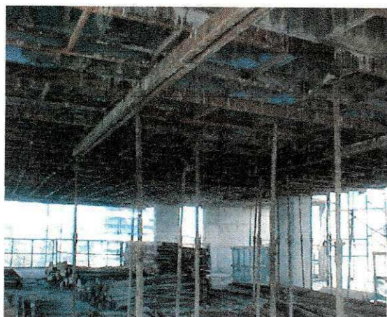
Figura 13. Suportes de sustentação da laje.
