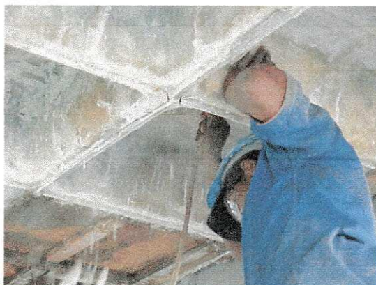
Figura 15. Retirada das fôrmas da laje
