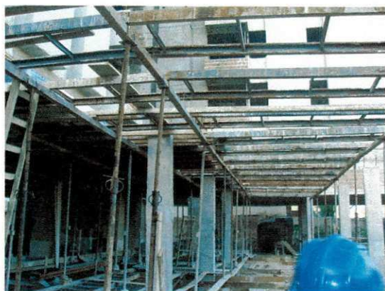
Figura 41 – Suportes metálicos para montagem das cumbucas da laje.
