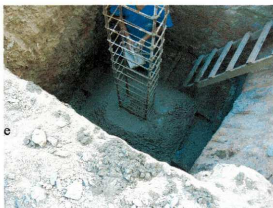
Figura 30 – Acabamentos finais da concretagem com uma desempenadeira.
