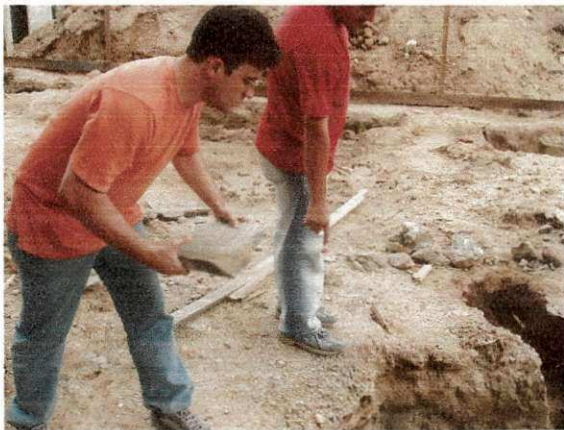
Figura 24 – Lançamento de matação dentro do concreto magro.
