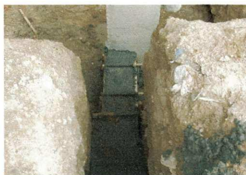
Figura 40 – Cinta depois de concretada.
