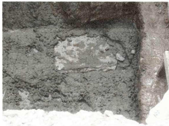
Figura 25 – Concreto ciclópico (mistura de concreto magro com pedaços de rochas).
