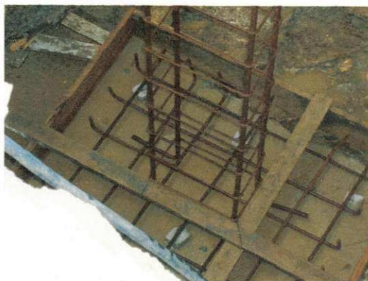
Figura 28 – Forma previamente molhada momentos antes da concretagem.
