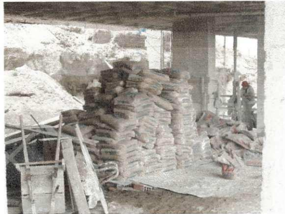
Figura 04 – Pilha de sacos de rebocal.
