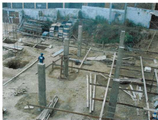
Figura 37 – Pilares depois de concretados.
