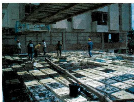
Figura 46 – Cumbucas untadas com desmoldante antes da concretagem.
