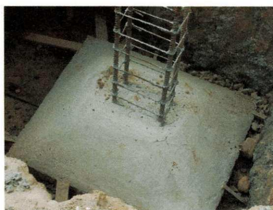
Figura 31 – Sapata pronta.
