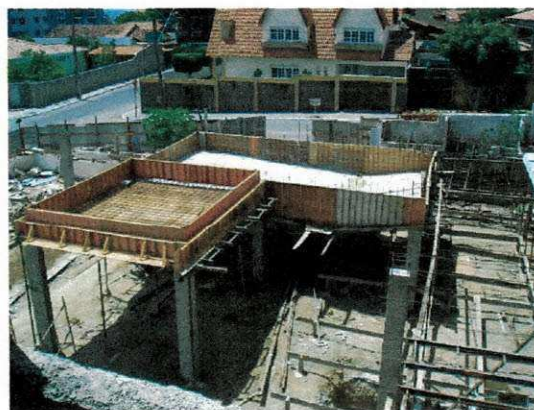
Figura 50 – Piscinas (lajes maciças).
