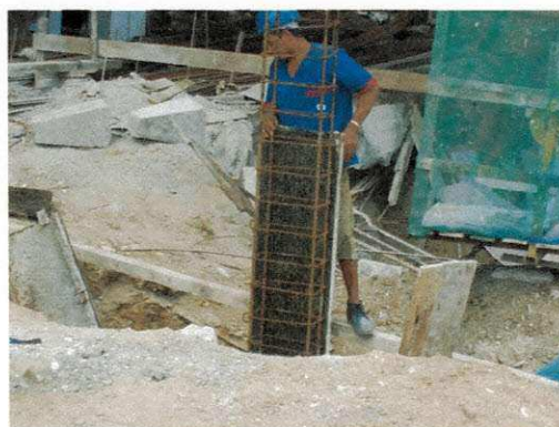
Figura 33 – Preparo da forma de um pilar.
