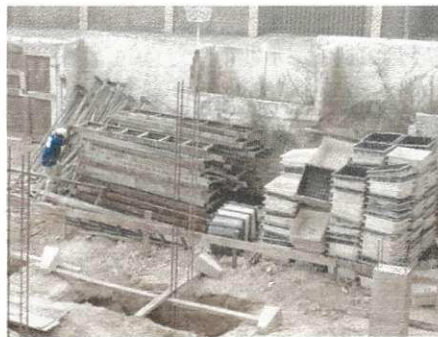
Figura 10 – Pilha de fôrmas de polipropileno.
