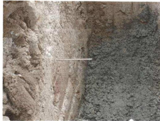
Figura 23 – Marco indicando o nível final que deverá ficar a camada de concreto magro
