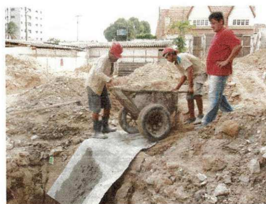
Figura 21 – Lançamento do concreto magro na vala.
