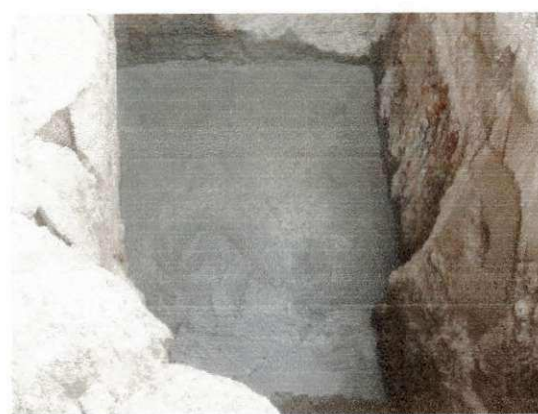
Figura 27 – Superfície regularizada pronta para receber a sapata.
