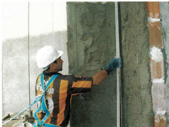
Figura 56 – Colocação do emboço na parte externa do edifício. .
