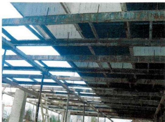
Figura 43 – Detalhe das escoras metálicas e de grampos prendendo as cumbucas.
