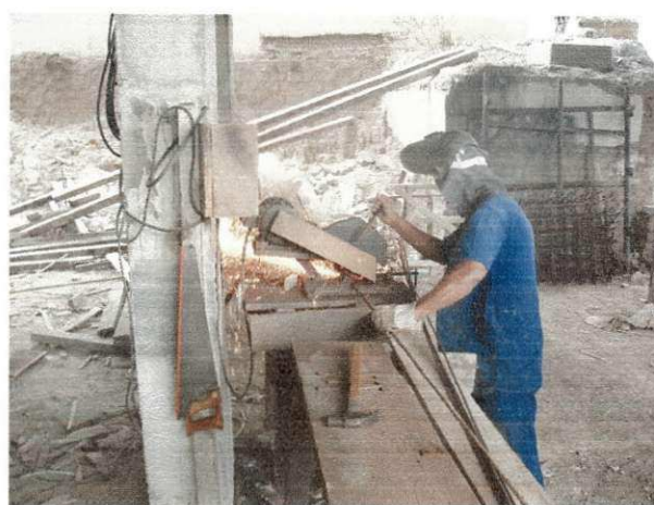
Figura 08 – Local onde fica o ferreiro (debaixo do corpo da edificação da parte norte).
