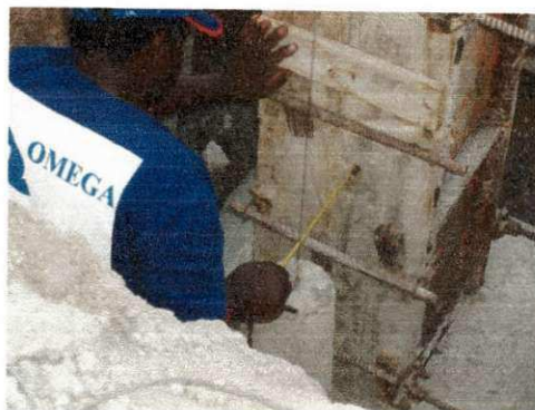
Figuras 17 – Utilização do prumo improvisado com um arame e um peso pendurado na ponta.
