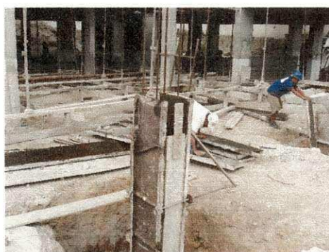
Figuras 11 e 12 – (Fôrmas de aço dos pilares)
