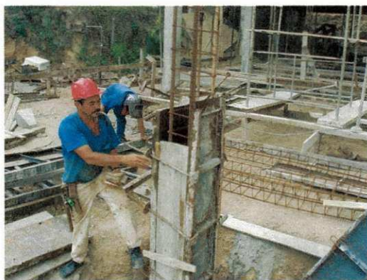
Figura 36 – Preparo da forma do pilar.
