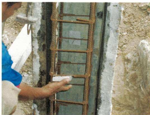
Figura 34 – Colocação de ‘cocadas’ para garantir a espessura correta do recobrimento.
