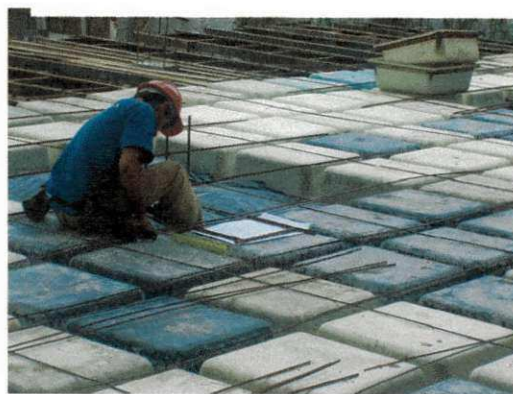
Figura 44 – Colocação das ferragens entre as fôrmas.
