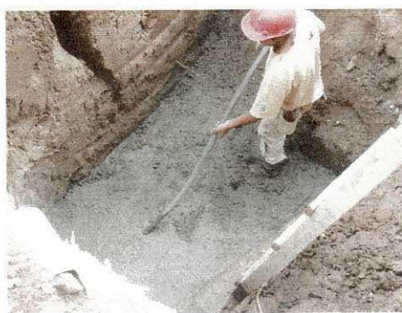
Figuras 13 e 14 – Vibrador de imersão.
