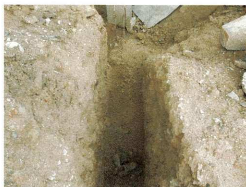
Figura 39 – Vala onde será concretada a cinta.
