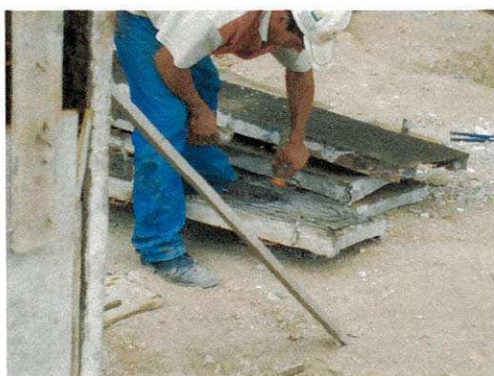
Figura 32 – Colocação de desmoldante nas fôrmas dos pilares.
