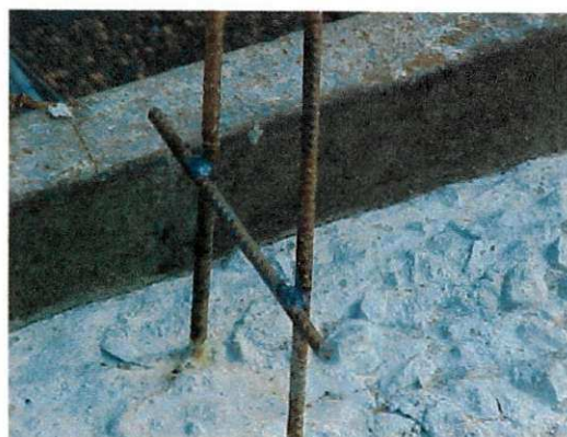
Figura 35 – Peça de ferro soldado às barras para garantir a espessura correta de recobrimento.
