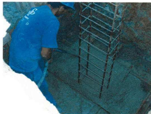
Figura 29 – Concretagem da sapata. (Operário utilizando vibrador para homogeneizar o concreto)
