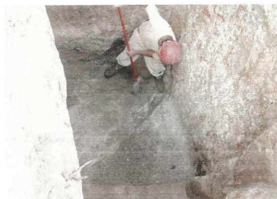
Figura 20 – Preparação e limpeza da superfície antes do lançamento do concreto magro
