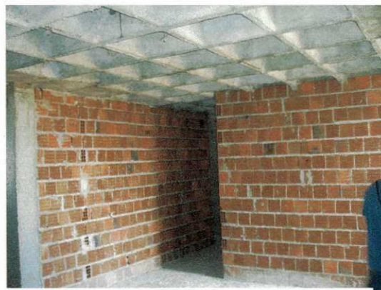
Figura 52 – Alvenaria já levantada em um dos apartamentos.
