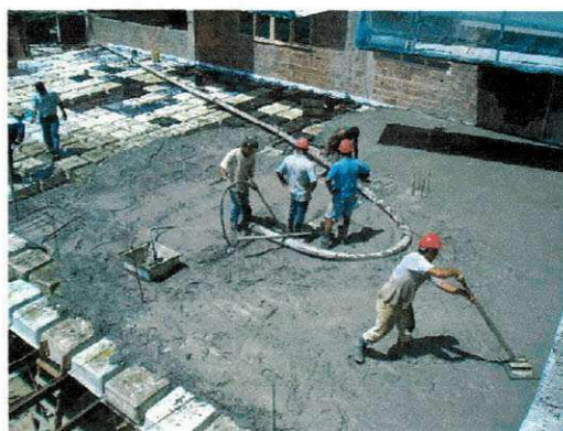
Figura 48 – Concretagem da laje.
