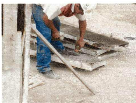
Figuras 11 e 12 – (Fôrmas de aço dos pilares)
