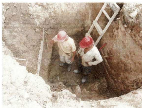
Figura 19 – Vala onde será assentada uma sapata
