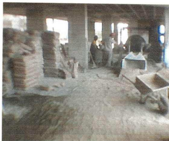
Figura 06 – Depósito de materiais junto à betoneira. Do lado esquerdo fica o elevador de carga.
