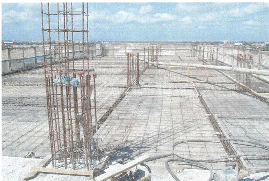
Figura 5 – Detalhe das armaduras de um pilar.
