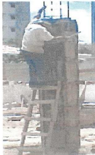
Figura 3.- Retirada da fôrma de um pilar.
