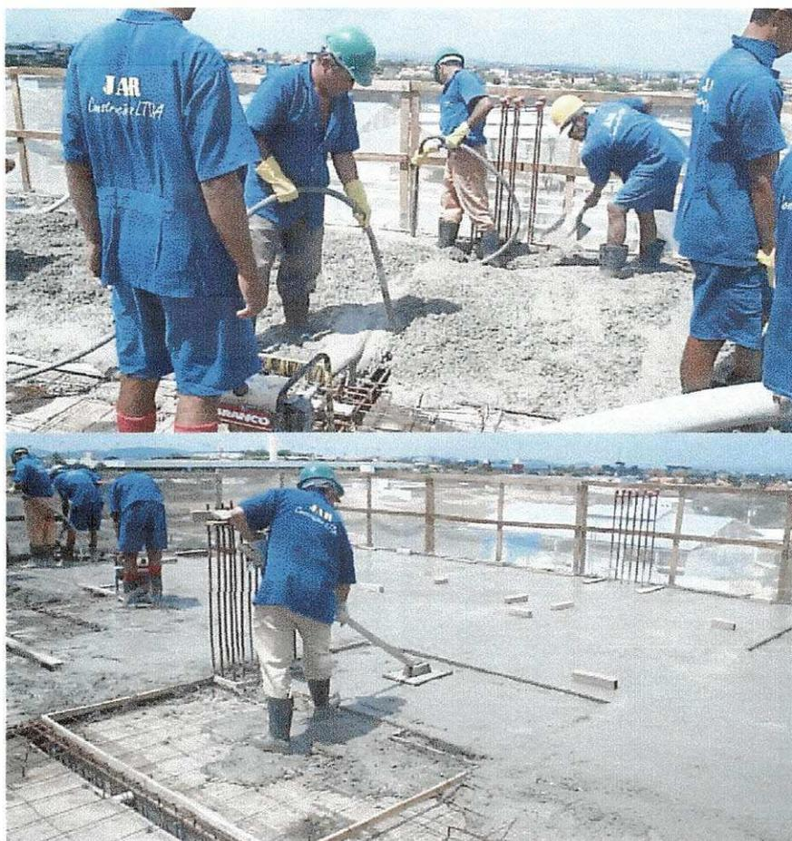
Figura 7 – Concretagem de lajes e vigas.
