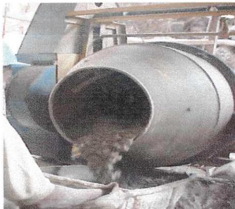
Figura 2 – Preparação do concreto na betoneira
