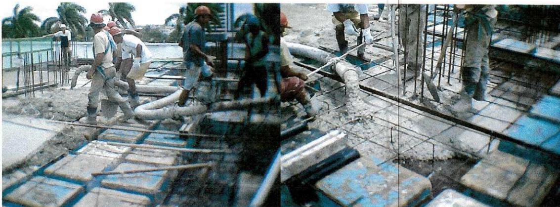
Figura 20, 21 – Concretagem mecanizada, onde o concreto é fornecido por dutos.
