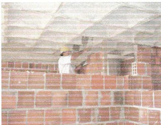
**Figura 21 – Assentamento das alvenarias**
