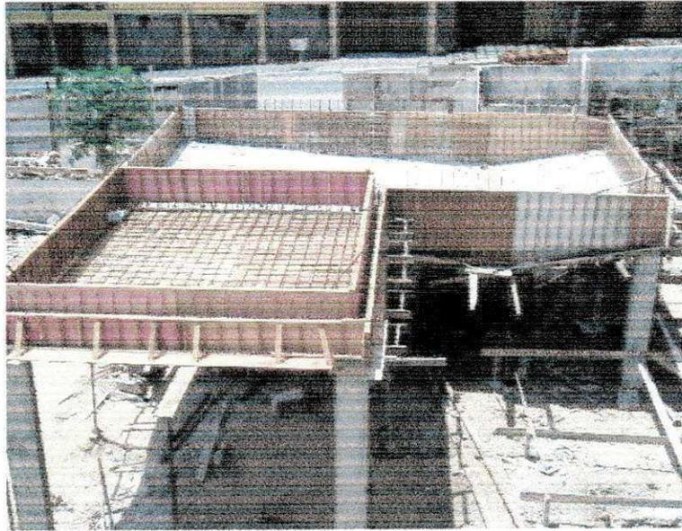
**Figura 27 – Fôrma, ferragem e concretagem da piscina**
