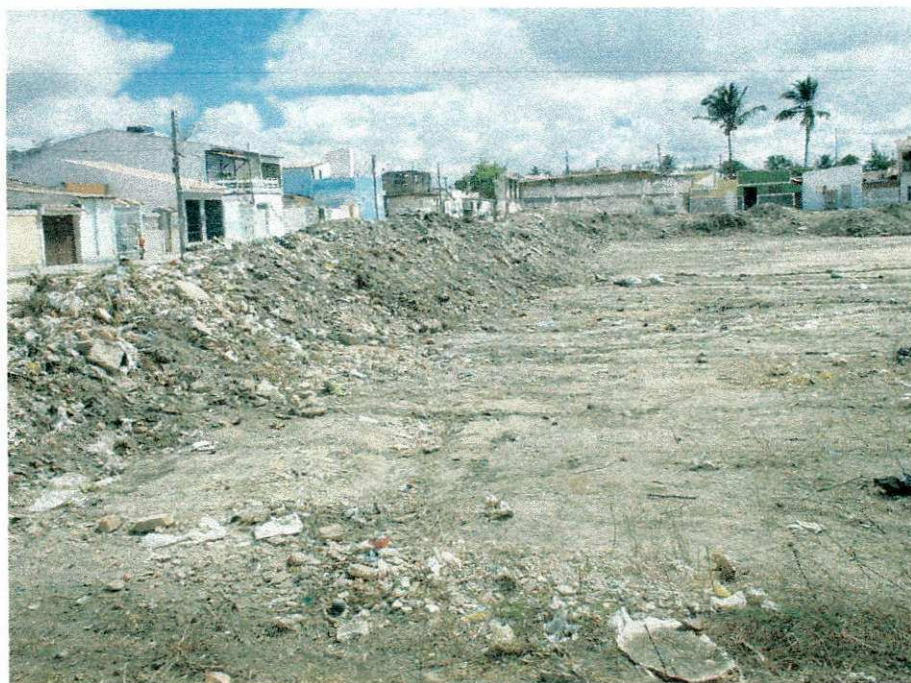
FIGURA 08 – Terraplanagem da construção.
