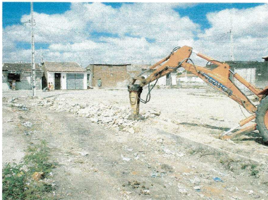
FIGURA 01 – Uso de máquina para demolição de concreto.
