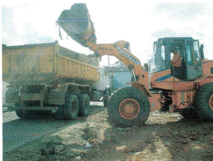
FIGURA 03 – Remoção de resíduos de demolição
