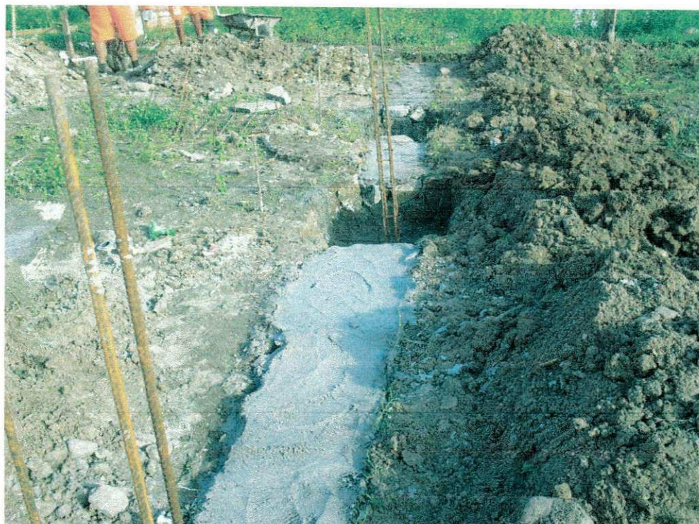
FIGURA 31 – Alvenaria de pedra argamassada da fundação do núcleo policial.
