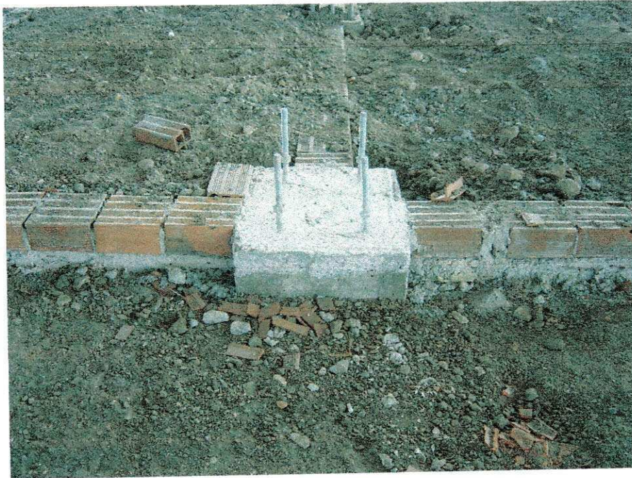
FIGURA 11 – Sapata isolada (Ginásio).
