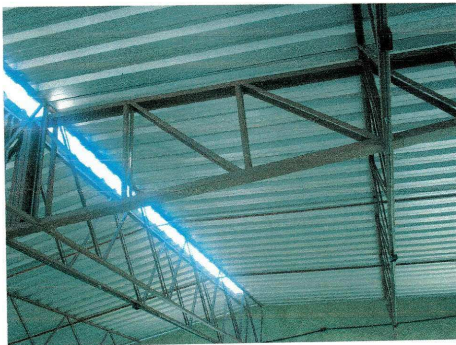
FIGURA 32 – Cobertura metálica do museu .
