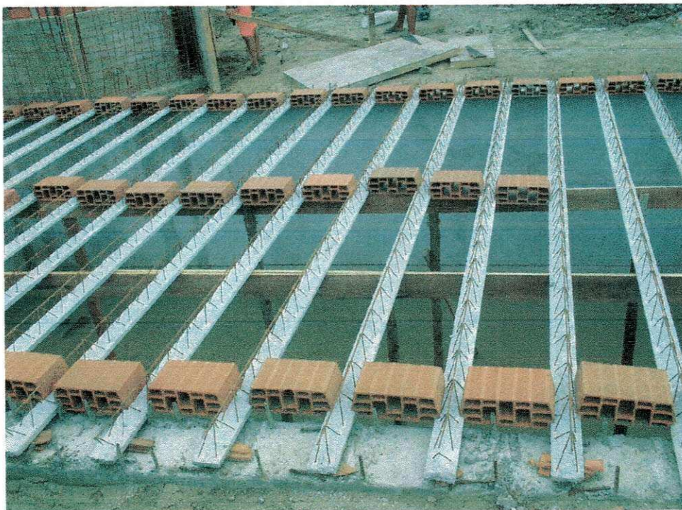
FIGURA 15 – Laje pré-moldada do reservatório inferior.
