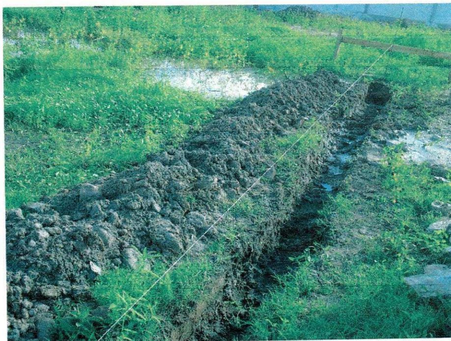
FIGURA 09 – Escavação de vala(Posto policial).
