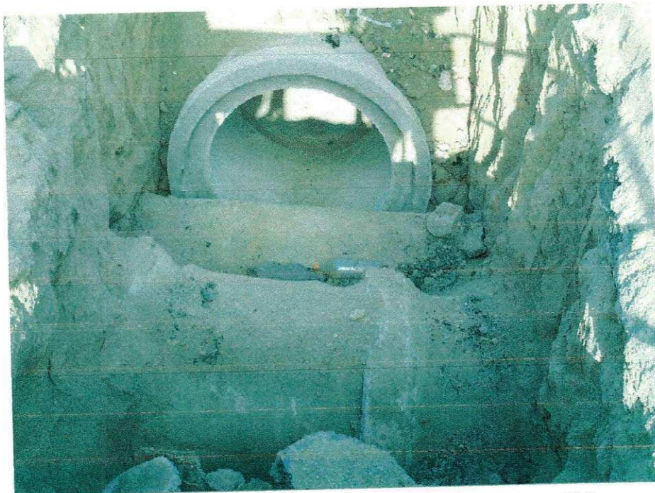
FIGURA 39 – Encontro da rede de drenagem com a rede de esgoto sanitário.
