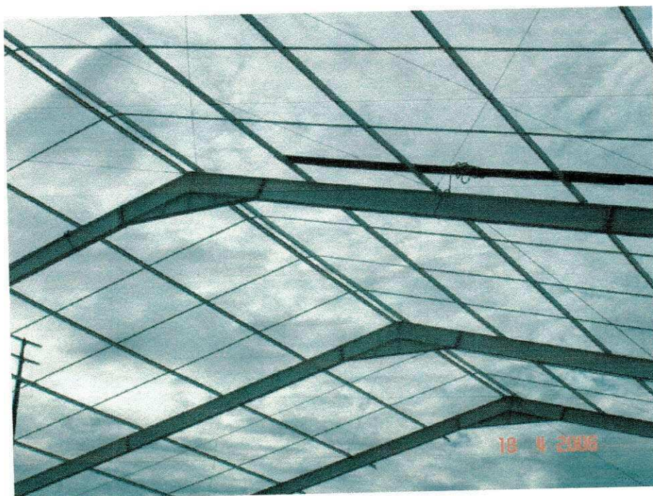
FIGURA 21 – Estrutura da cobertura em aço do ginásio
