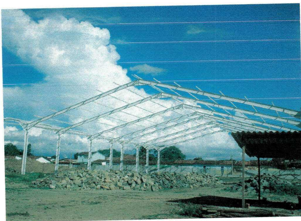
FIGURA 25 – Estrutura principal do ginásio
