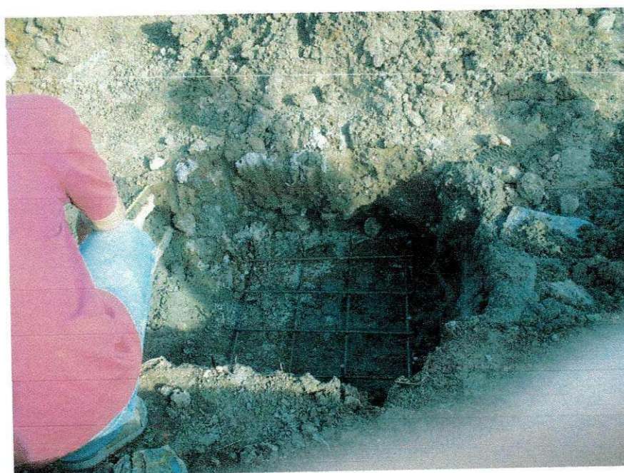
FIGURA 10 – Escavação de vala (sapata isolada).
