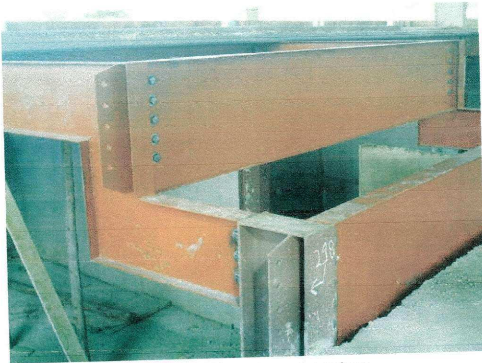
FIGURA 26 – Vigamento em estrutura de aço
