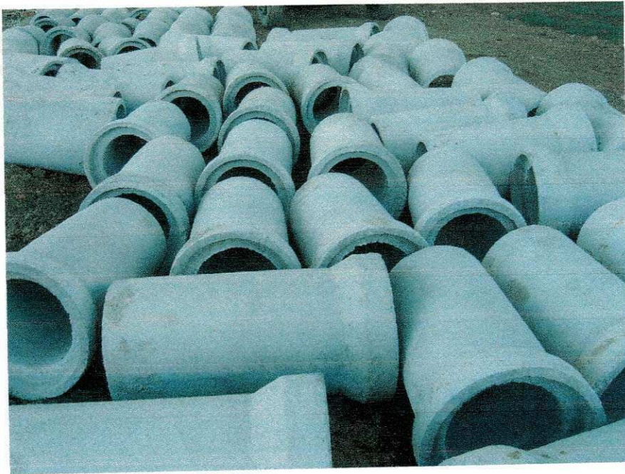
FIGURA 36 – Tubos em concreto armado utilizados na rede de drenagem.
