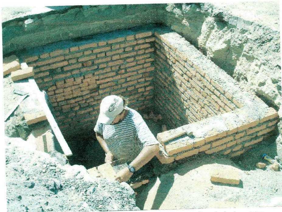
FIGURA 37 – Construção de uma caixa de inspeção da rede de drenagem.
