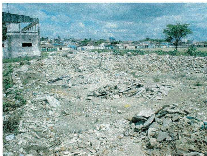
FIGURA 02 – Resíduos de construção, demolição do museu
