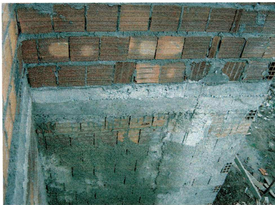
FIGURA 28 – Alvenaria de \frac{1}{2} vez do platimbanda da UBS.
