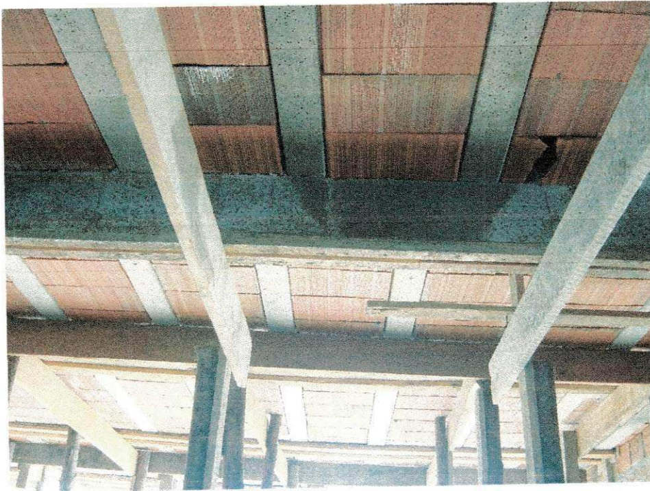
FIGURA 18 – Escoramento da laje pré-moldada da Unidade Básica de Saúde.
