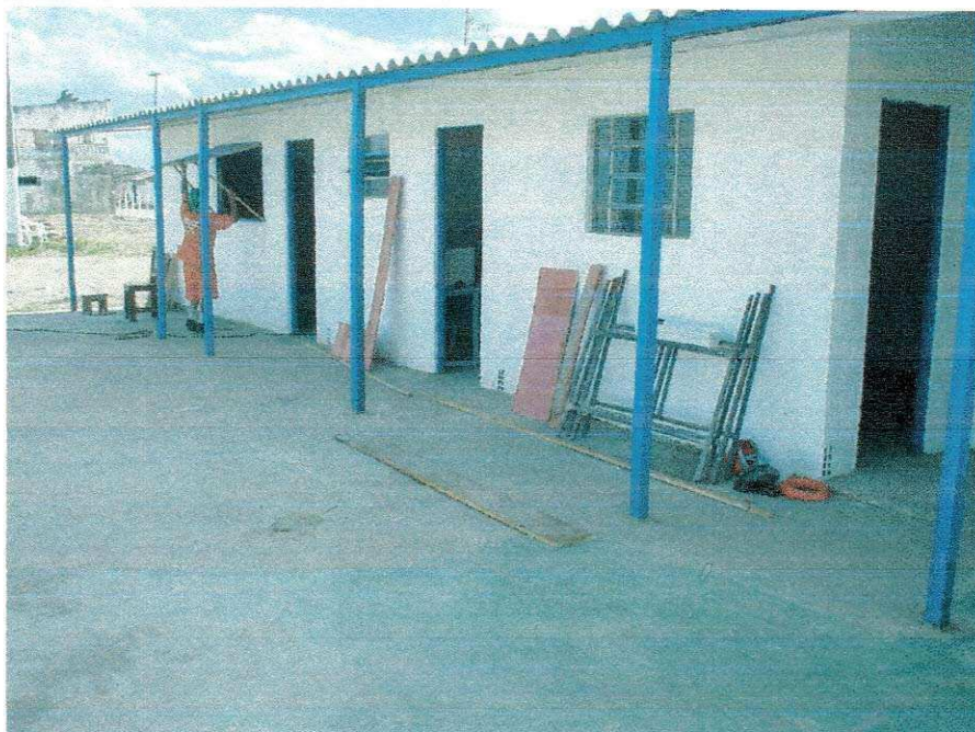
FIGURA 04 – Construção do acampamento.
