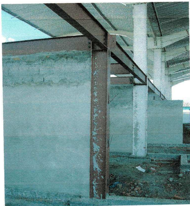
FIGURA 24 – Pilares e vigas do ginásio em aço
