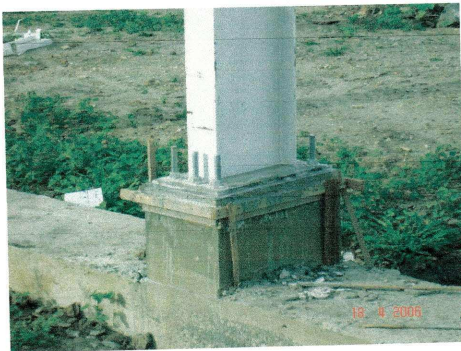
FIGURA 12 – Sapata isolada , pilar central (Ginásio).
