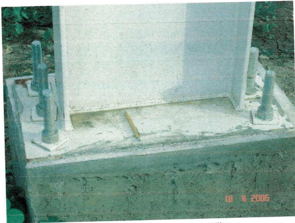
FIGURA 22 – Base para estrutura metálica
