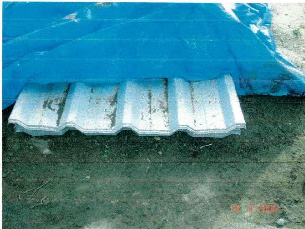
FIGURA 34 – Telha metálica para cobertura do ginásio.
