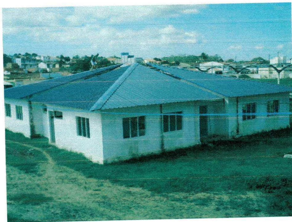
FIGURA 33 – Cobertura metálica do centro de capacitação .
