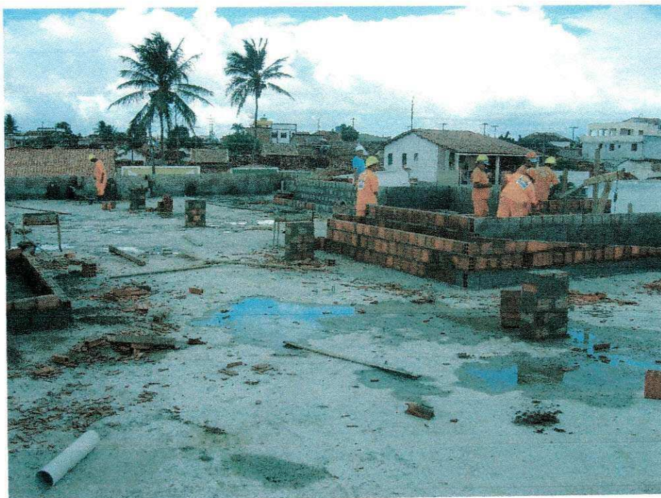
FIGURA 29 – Alvenaria do platimbanda da UBS.
