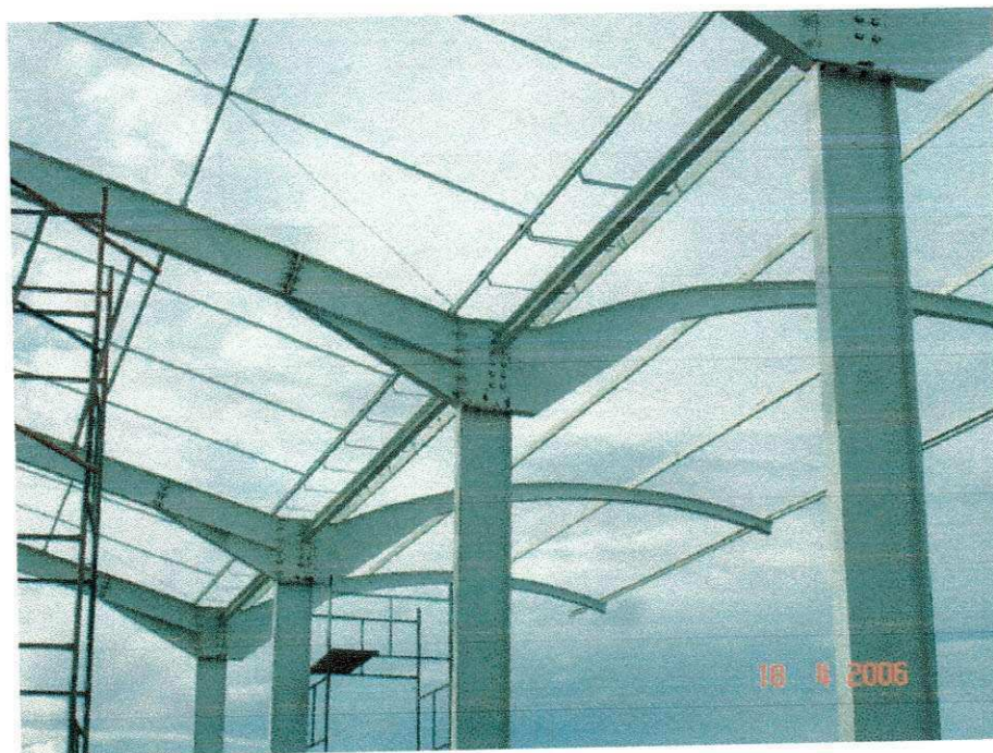
FIGURA 20 – Estrutura principal em aço do ginásio
