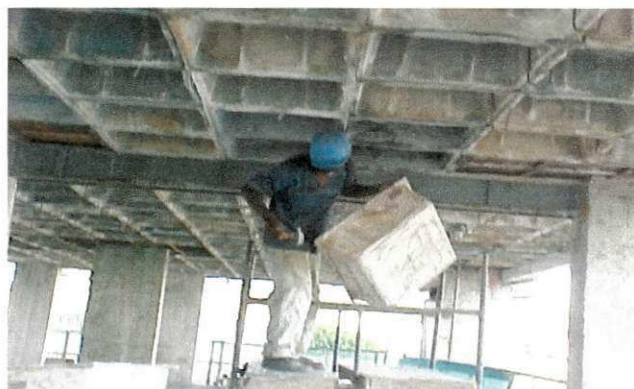
Figura 07 (Retirada das Fôrmas)
