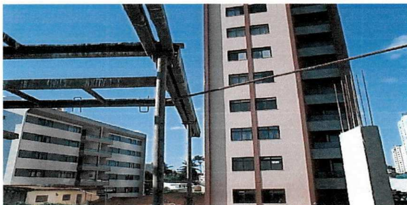
Figura 06 (Armação da Laje)
