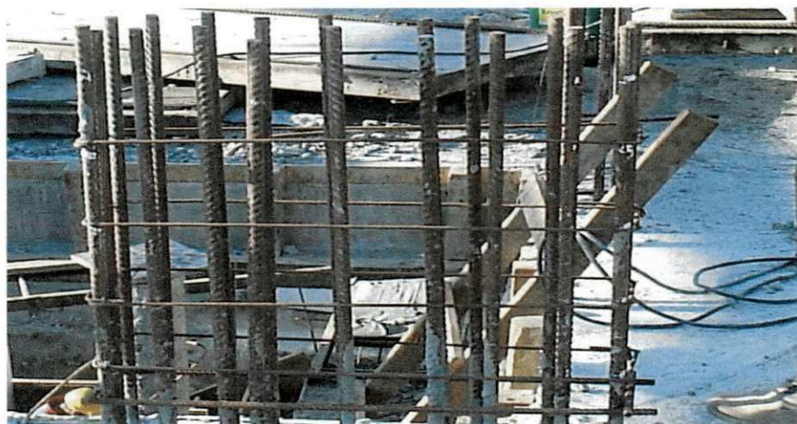
Figura 07 (Ferragem dos Pilares)
