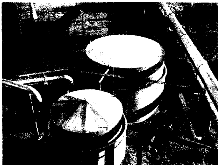
Figura 5.12 – Lavadores de gases
