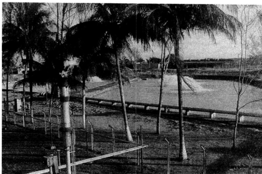
Figura 5.14 – Lagoas de Aeração
