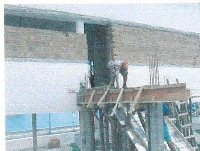
**Figura 16 – Colocação de armadura (sem EPI's)**
