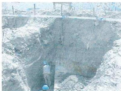
Figura 01 – Limpeza e regularização (observar o gabarito ao fundo).
