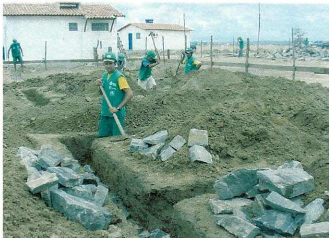
Figura 2: Alvenaria de pedra de mão calcária argamassada.
